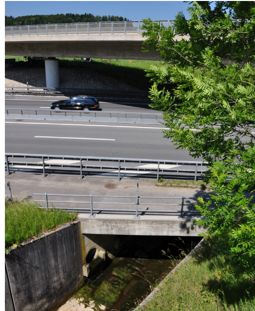
« Passage » du Dâ, vue en direction du Plateau.
