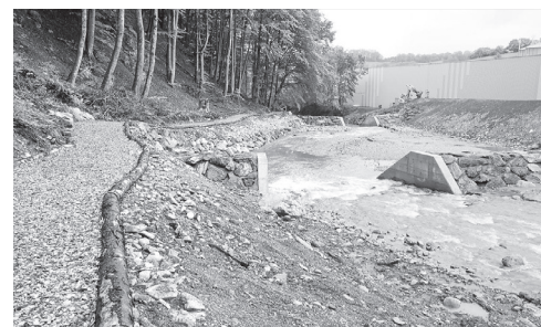
Figure 39: zone d'épandage des sédiments créée sur la Veveyse de Châtel, la mesure la plus importante prise pour l'aménagement de la rivière.
