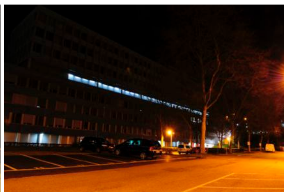
Figure 45 : Parking mal éclairé et mal aménagé Source : Photographie P. Kohli, 2015
