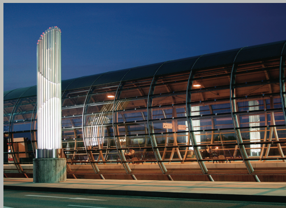
Image 41. Couverture et éclairage d'un arrêt de tram.
