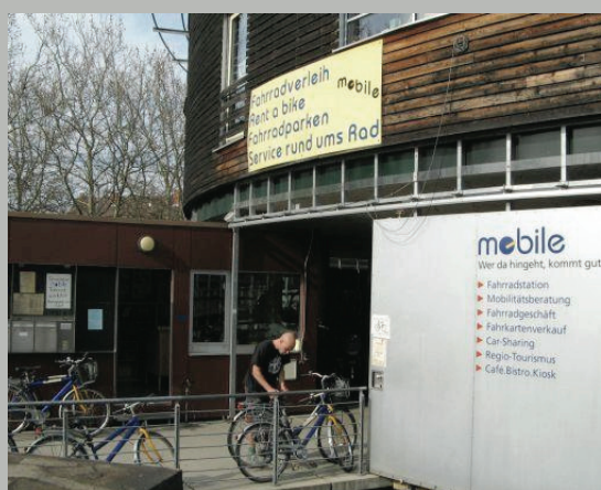
Image 39. Parking, service de prêt et réparation pour vélos.
