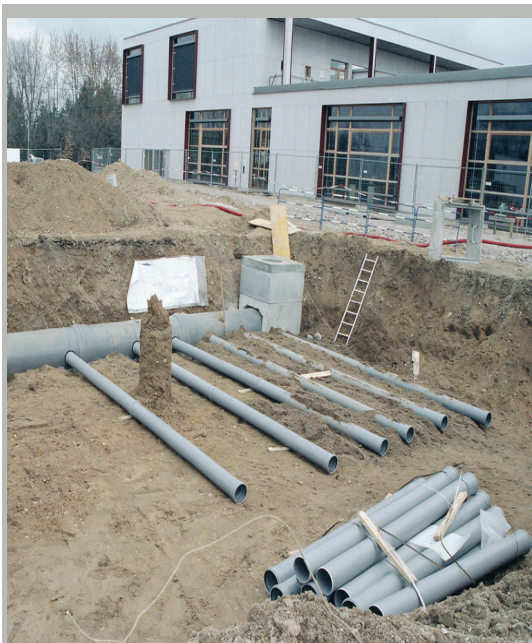
Image 56. Chantier d'installation d'un puits canadien.
