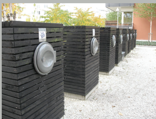
Image 48. Collecte souterraine sous vide.
