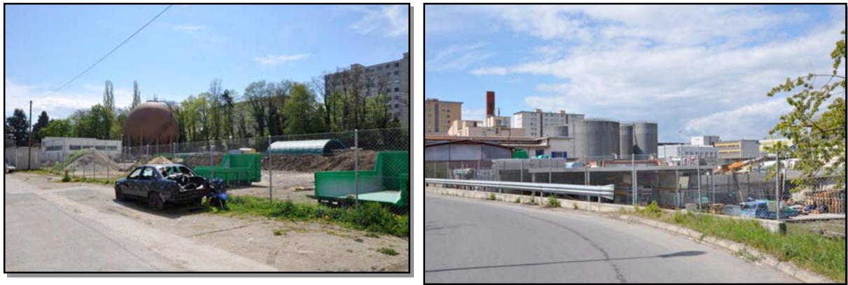
Figure 24. Les traces de l'affectation industrielle : à gauche l'ancienne boule à gaz et à droite, les actuelles cuves pour le stockage de mazout.
