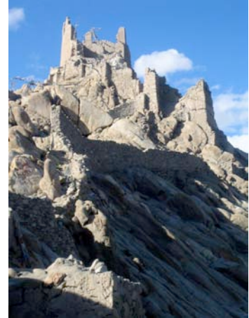
Photo 42 : Fort datant du Xe siècle, le plus haut et le plus ancien édifice du complexe de Shey.
