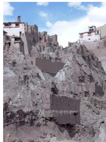
Photo 73 : Au premier plan, on remarque les surplombs sous les murs des ruines. En arrière-plan, nous voyons la hauteur des fondations rénovées.
