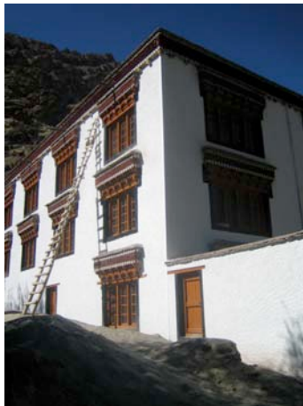
Photo 18 : Partie rénovée du monastère avec en arrière plan les roches molassiques (photo R. Boillat).
