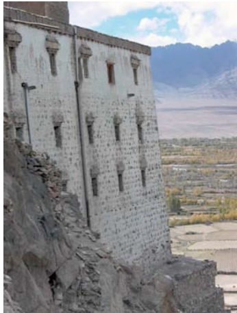
Photo 64 : Les fondations, formées de blocs de granite, épousent le relief.
