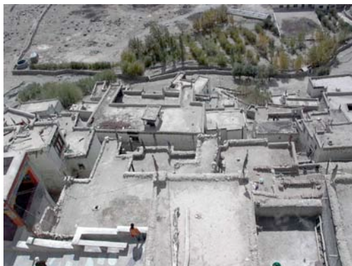
Photo 84 : Vue sur les toits de Thikse. Nous notons les balcons-terrasses protégés par les pièces latérales. C'est un des éléments typiques de l'architecture climatique ladakhie.
