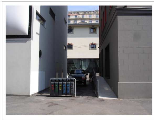
Figure 32 : Couloir de connexion perpendiculaire (Source : Ilan Losa)
