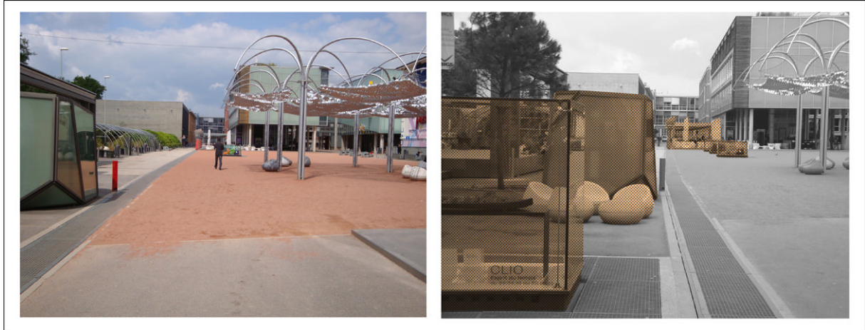
Figure 27 : Brusque discontinuité du revêtement du sol et obstruction visuelle par le mobilier urbain (Source : Ian Losa)
