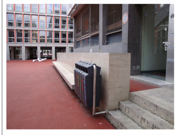
Figure 72 : Banc public en béton (Source : Ian Losa)
