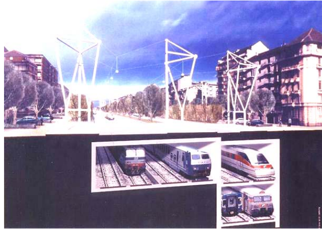
Figure 43 : structure du Passante Ferroviario à la suite de l'enterrement des voies ; en surface boulevard de Spina Centrale.
