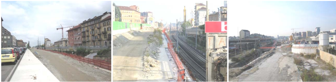
Figure 19 : travaux pour l'enterrement du Passante Ferroviario.
