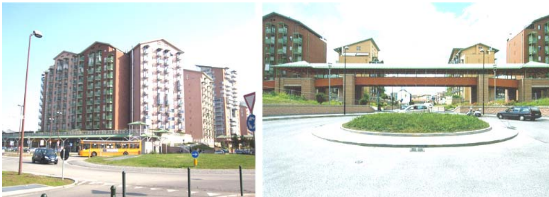
Figure 32 : vue panoramique du secteur Valdocco et des passerelles suspendues.
