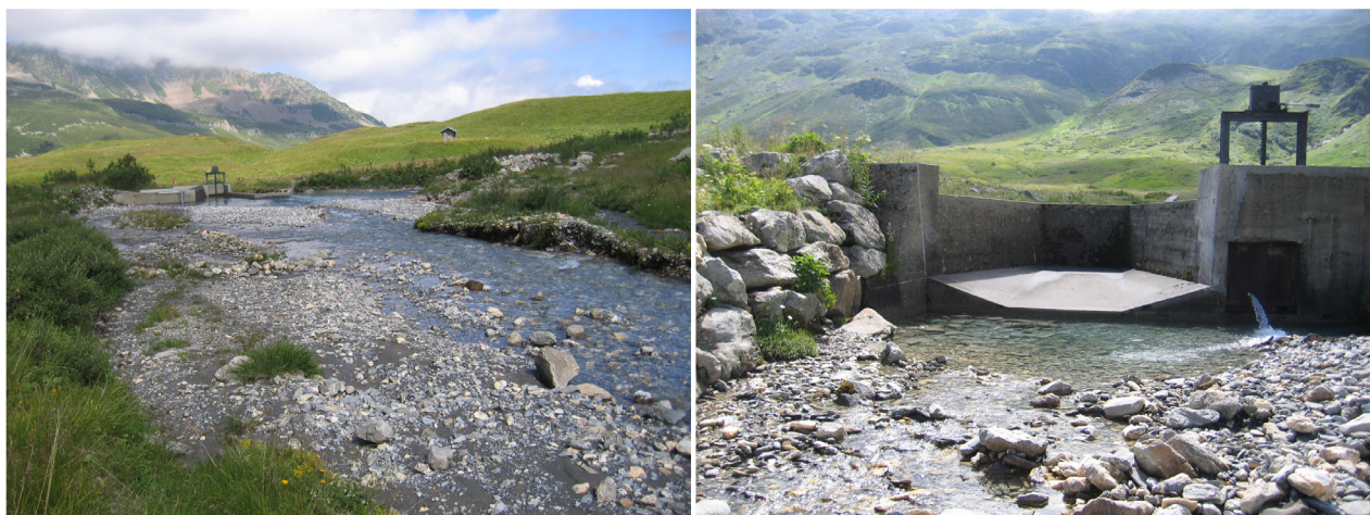
Figure 7.6 et figure 7.7 : amont et aval du captage d'eau de la Plan Jovet (il alimente le barrage de la Girotte en Savoie). La faiblesse du débit du Bon Nant à la sortie de ce captage se traduit par une diminution de la compétence du cours d'eau et donc de son activité morphogénétique
