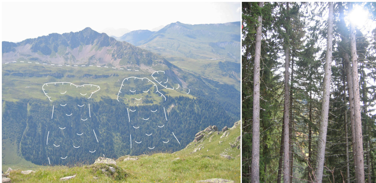
Figure 5.52: L'aiguille de Roselette et le versant de la Rollaz. Les glissements de terrains qui touchent les schistes et la couverture morainique, prennent naissance dans des secteurs marécageux. Ils se traduisent par des dépressions à l'amont et par le bombement de la partie aval (déformation du rebord d'auge glaciaire de la Rollaz). Le tassement rocheux semble toucher l'ensemble du versant depuis la base des escarpements de Roselette (traitillés en haut de la photo). Figure 5.53: Forêt déstabilisée sur la couverture morainique de la Côte d'Auran (1300m), au dessus du Cugnon. L'inclinaison (dans différentes orientations) des troncs illustre un mouvement de terrain superficiel et récent (les arbres poussent à la verticale et leurs troncs ont tendance à se redresser quand ils sont déstabilisés, ce qui n'est pas encore le cas sur la photo).
