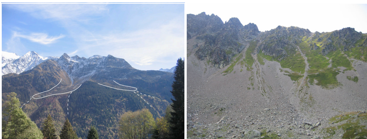
Figure 5.69: Zones de dépôts d'avalanches dans la Combe du Chaborgne (à gauche, le Nant des Tours et à droite, le Nant des Grassenières). La végétation automnale contrastée (aulnes et autres essences contre pessière climacique) met en évidence les secteurs fréquemment parcourus par les avalanches. Les lignes blanches marquent grossièrement les limites inférieures des avalanches de taille moyenne tandis que les avalanches exceptionnelles peuvent continuer vers la vallée principale dans les tirets. Figure 5.70: Eboulis polygéniques de la Tête de la Cicle. Ces formes, cartographiées comme gravitaires, résultent également des processus périglaciaires (fluage du matériel dans la partie basse), fluviatiles (ruisselement et dépôts de petites laves torrentielles prenant naissance dans les couloirs supérieurs) et nivales (dépôts non classés de matériel grossier et fin dans la partie distale par des avalanches de fond).
