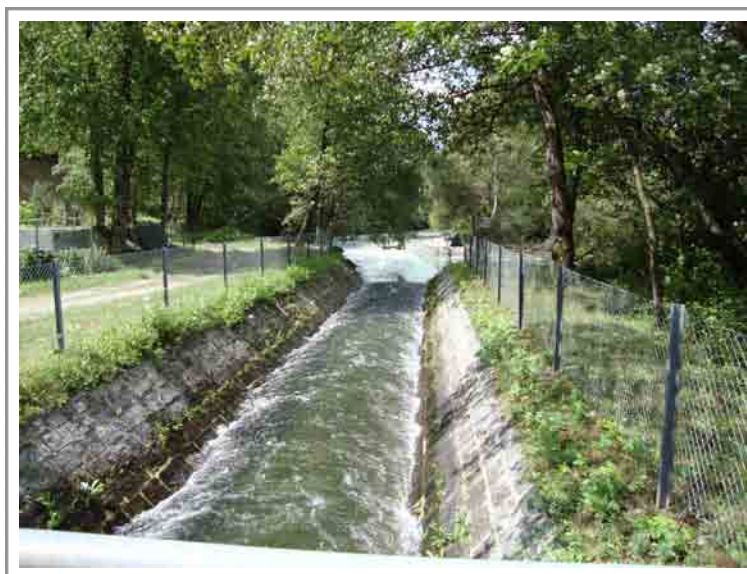
Figure 5.21 – Point de restitution des eaux turbinées par la centrale de Grono (GR).
