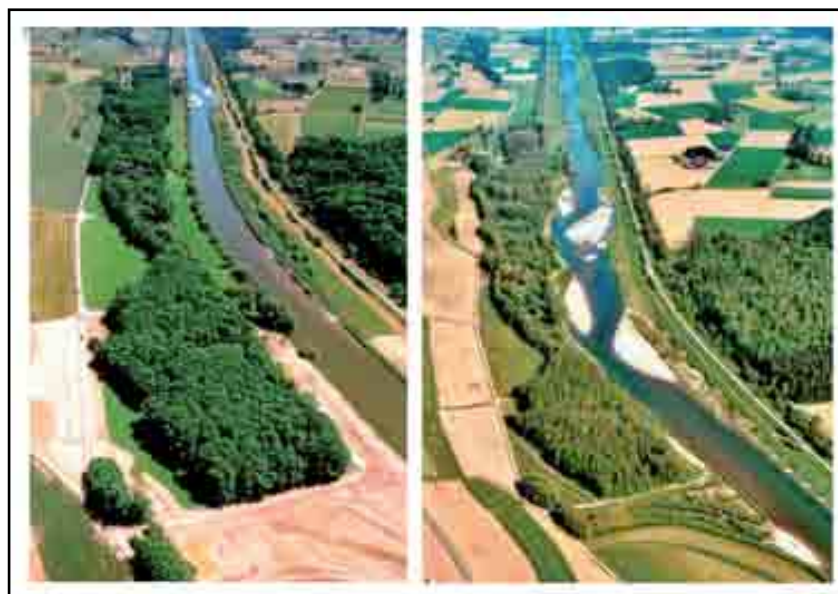
Figure 3.9 - Restauration localisée d'un tronçon de la Thur à Schöffäuli (TG). Dans la partie élargie est visible un dépôt de la charge de fond, dû à une réduction locale des forces tractrices résultant de l'élargissement du chenal (Malavoi et Bravard, 2010 ; Photo : C. Hermann, BHAtteam, Frauenfeld).
