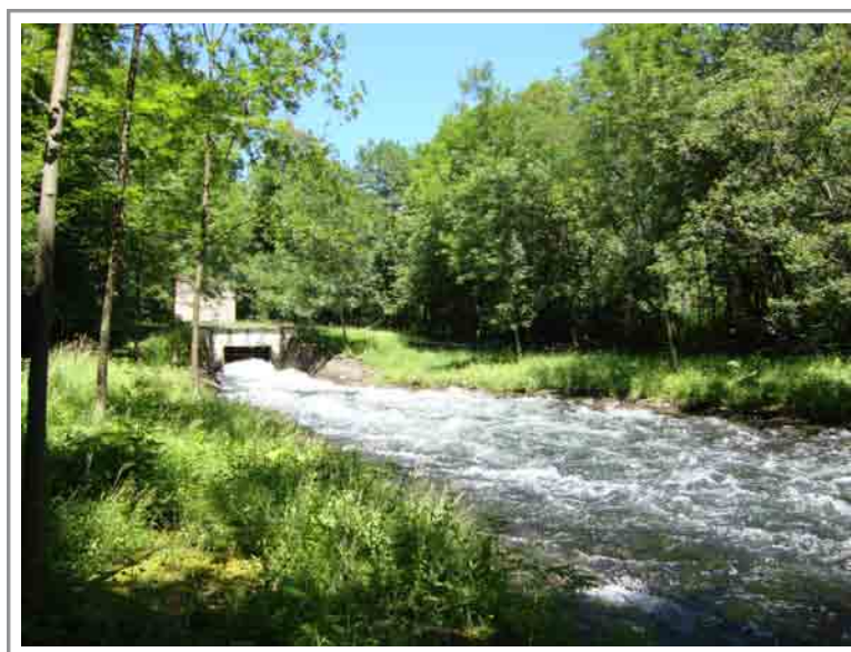
Figure 5.18 – Point de restitution des eaux turbinées de la centrale de Soazza.
