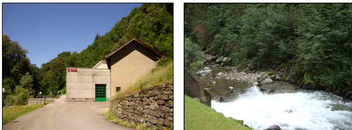
Figure 5.25 – La centrale de l'Aziende Municipalizzate Bellinzona (AMB) et son point de restitution.
