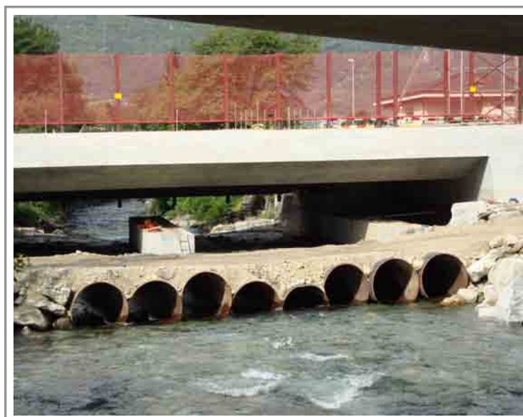
Figure 7.17 – Le passage sous tuyaux du troisième tronçon (720.472/114.368).
