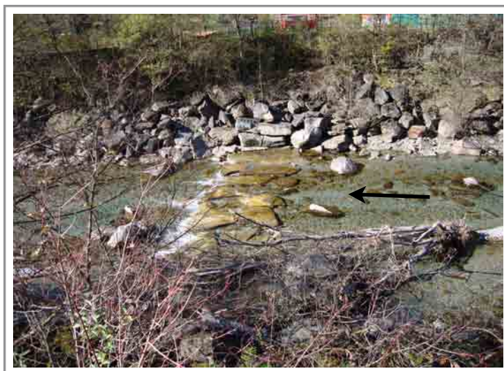
Figure 7.9 - La Moesa près de Cabiolo (GR). La photo montre l'aménagement du lit (seuils) et le renforcement du pied de la berge.
