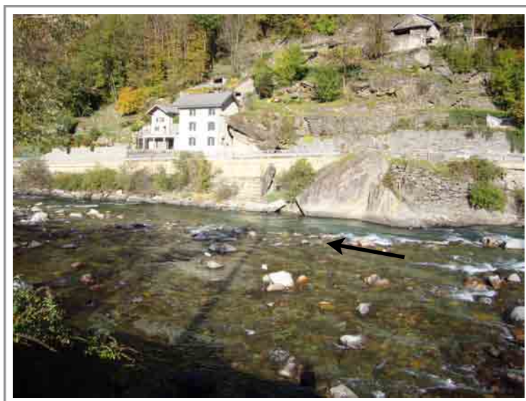
Figure 7.7 - La Moesa à Roveredo (GR) (tronçon 7) présentant un état écomorphologique “très atteint” (Classe III). A cause de la présence d’un mur de protection, la largeur des rives est nulle.
