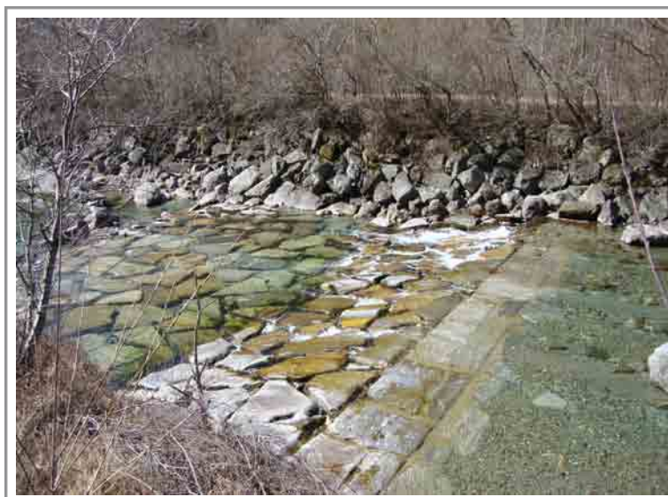
Figure 6.2 – Exemples de renforcement de pied de berge et d'aménagement du lit (Moesa à Cabiolo, GR). Dans ce cas, pendant le débit plancher, cet aménagement à gros blocs correspond à un obstacle à la libre circulation des poissons.
