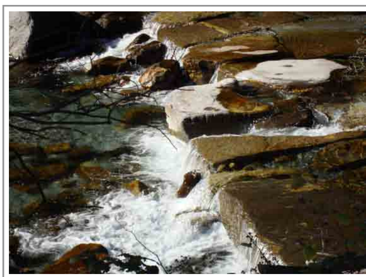
Figure 7.10 - Un des nombreux seuils présents le long du tronçon 19 (736.131/131.917). Cette photo a été prise pendant le débit plancher.
