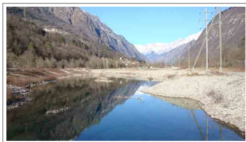
Figure 7.12 - Exemple d'intervention le long de la Moesa à Leggia (732.731/124.151) avec la création d'un bassin refuge.
