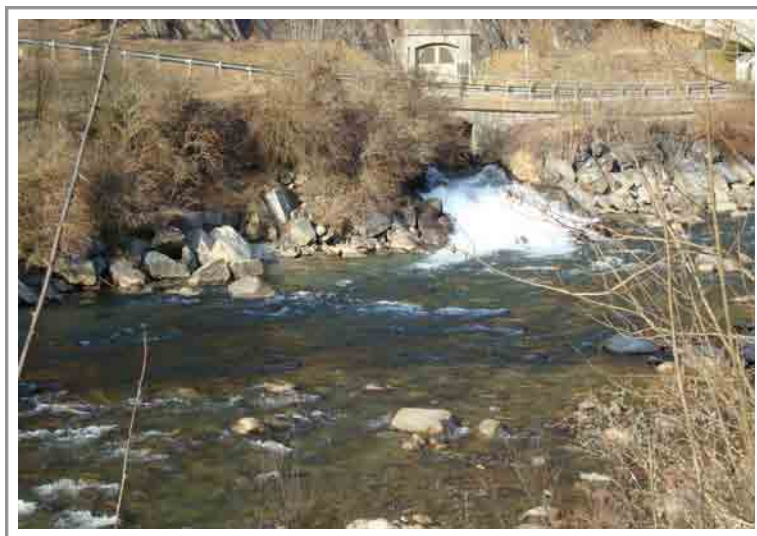
Figure 5.22 – Point de restitution des eaux de la centrale souterraine de San Vittore (GR).
