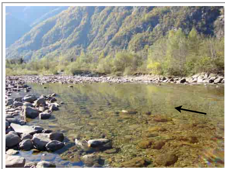
Figure 7.5 – Le tronçon 18, Golena Rosera (GR). En 1995, des interventions d’amélioration de la dynamique et de renforcement de la rive droite ont été réalisées pour protéger l’autoroute. Cette unité fluviale est désignée comme zone alluviale d’importance nationale (objet n°161, de l’inventaire fédéral des zones alluviales 11 ).
