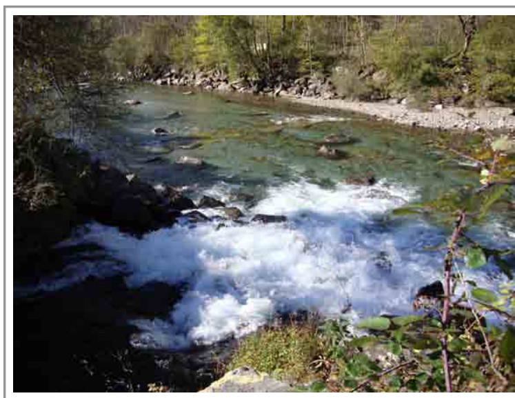
Figure 5.19 – Point de restitution de la centrale de Lostallo (GR).
