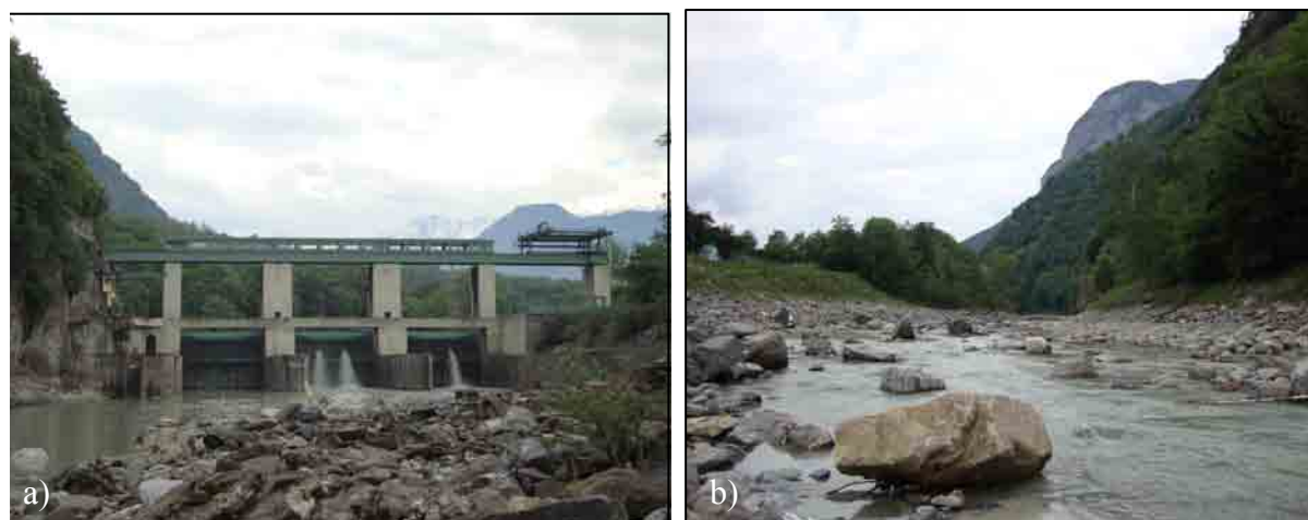
Figure 4.3 – a) Barrage hydroélectrique au fil de l'eau (le Rhône à Lavey, VS). b) Après le barrage, le Rhône est à débit résiduel, la vitesse d'écoulement est nettement inférieure et le transport des sédiments limité, ce qui favorise le colmatage.
