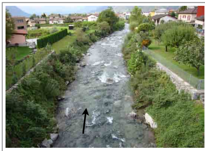
Figure 7.18 – Tronçon numéro 4 pendant le débit d'éclusée. La structure et les rives, dont la largeur est insuffisante, sont artificielles.
