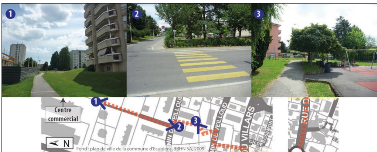
Figure 15 : Aspect général de la route au sud, segment 1 (du centre commercial à la fin des sentiers)
