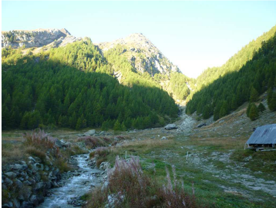
Figure 4.16 : Renforcement des berges du torrent par de gros blocs.
