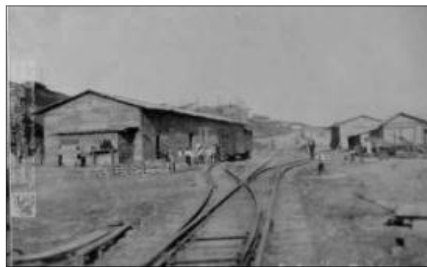
Photo 3. Ancienne voie ferrée direction la mer Pacifique
