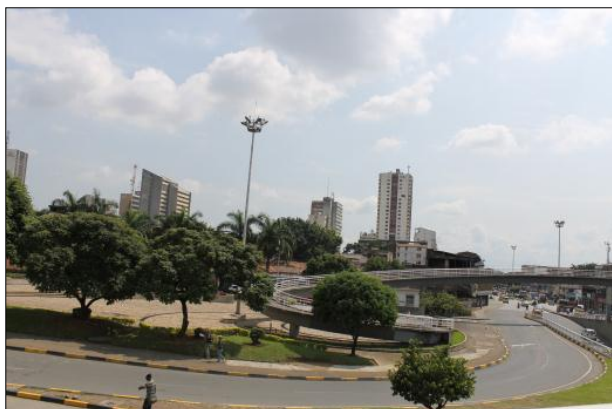
Photo 20. Entrée au centre-ville par un pont sur la carrera 10 Source : Patricia Gómez (Février 2012)
