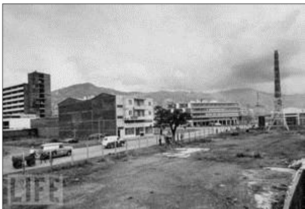
Photo 4. Le centre-ville après l'explosion
