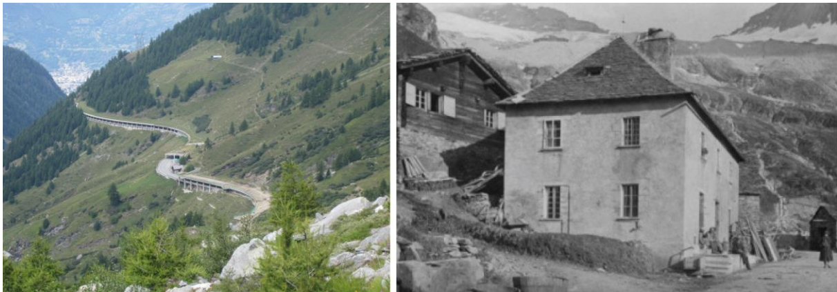
Fig. 3.7 : Galerie protégeant la route du col (gauche) et habitations à Schallbett (droite) (Arnold, 1917). Le chalet sur la gauche a été emporté lors d'un évènement torrentiel en 1993
