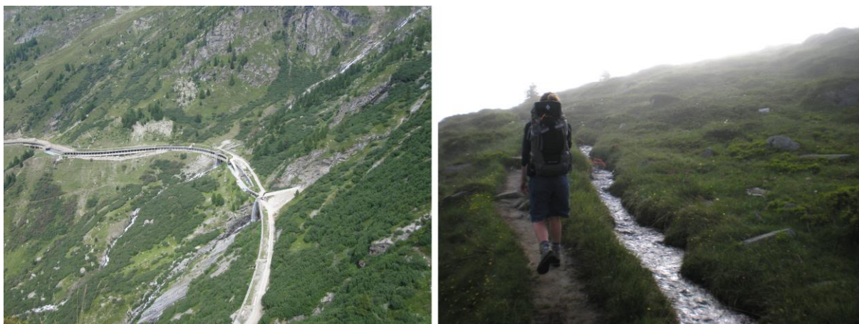
Fig. 4.14 : Galerie protégeant la route du col (gauche) et chemin longeant le bisse en amont du col (droite)
