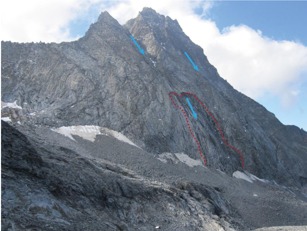
Fig. 4.10 : Niche d'arrachement de l'éboulement du Hübschhorn (rouge) et ravinement sur la paroi en août 2012 (flèches bleues)
