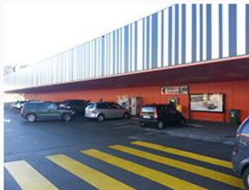
Entrée de la Migros
