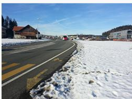
Cheminement piéton depuis l'arrêt Mobul
