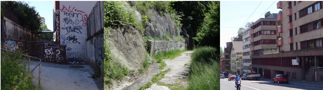
Figure 36 : Espaces vieillissants et dégradés à la Borde
