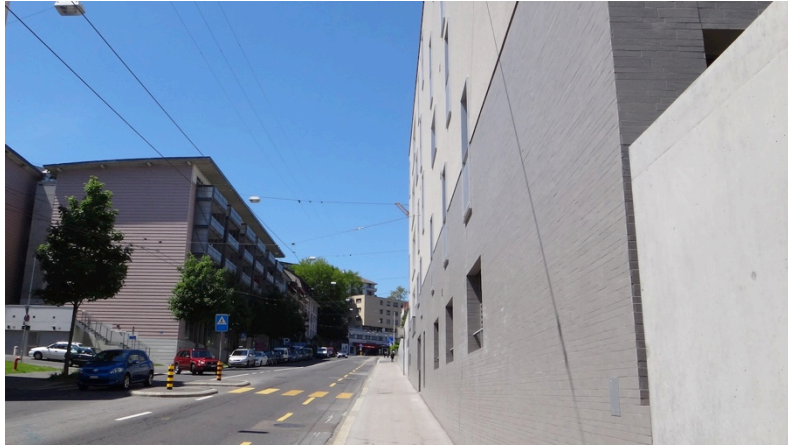
Figure 22 : Front bâti du haut de la rue de la Borde
