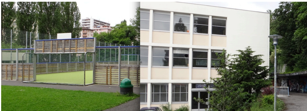
Figure 26 : Terrain de sports (à gauche) et Collège de la Borde (à droite)
