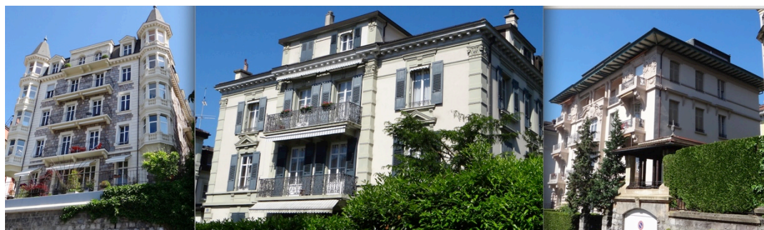
Figure 63 : Immeubles de standing et maisons de maître à Florimont
