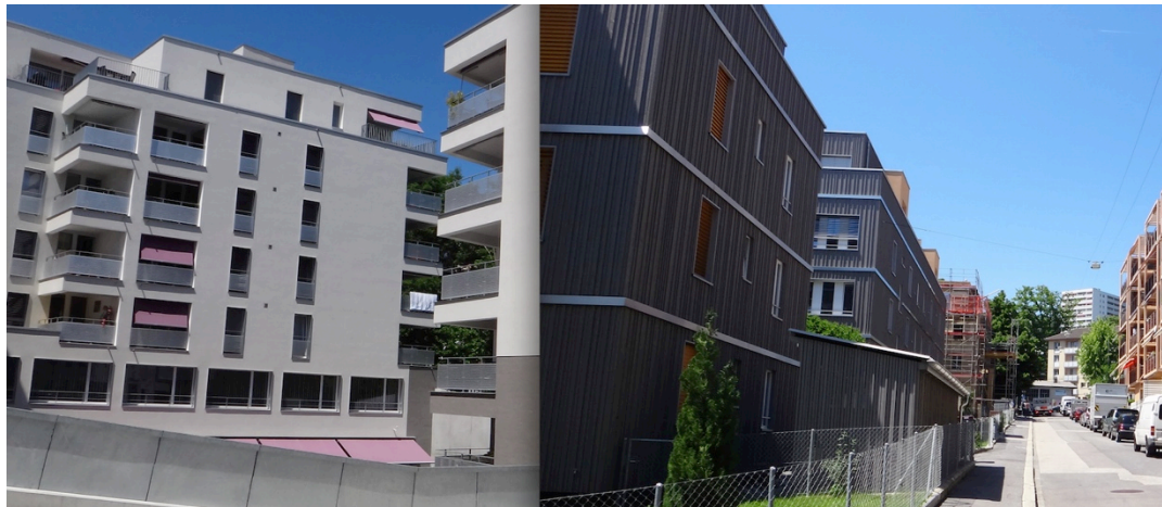
Figure 33 : Nouvelles constructions du haut de la Borde
