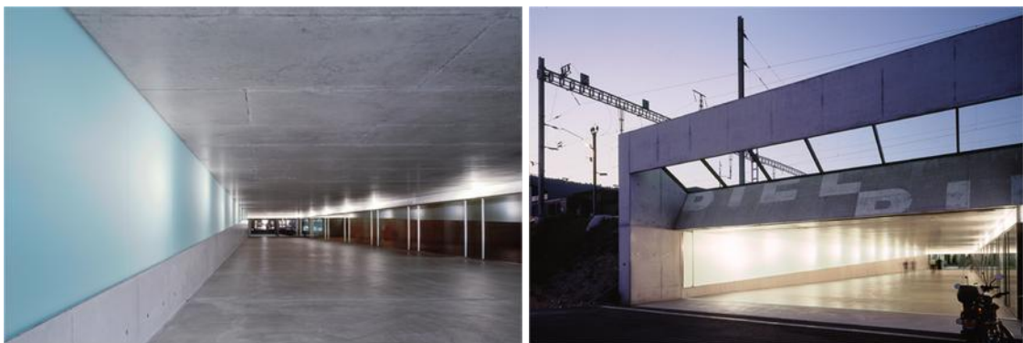
Figure 24 : passage sous-voies de la gare de Bielne, après son prolongement en 2001 (Source : kistler-vogt.ch)
