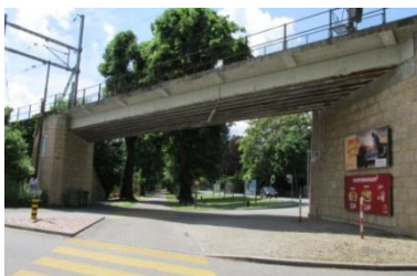
Figure 57 : passage sous-voies au Faubourg du lac, rue du Viaduc (Source : Meier, 2014)
