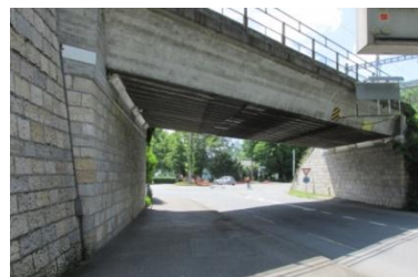
Figure 58 : passage sous-voies avant la jonction du Faubourg du lac (Source : Meier, 2014)
