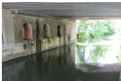
Figure 52 : passage sous-voies, Quai du Bas (Source : Meier, 2014)
