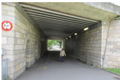
Figure 51 : passage sous-voies, Quai du Bas (Source : Meier, 2014)
