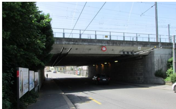
Figure 62 : passage sous-voies à la rue d'Aarberg (Source : Meier, 2014)
