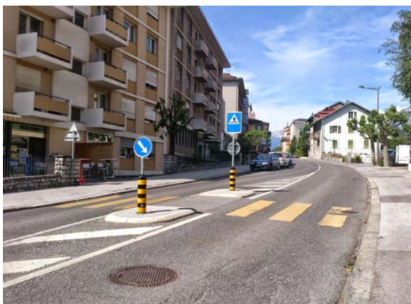
Photo 42 : Absence d'éclairage dans les îlots [Buchard, 2014]
