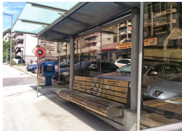
Photo 43 : Arrêt de bus sur la rue du Scex [Buchard, 2014]
