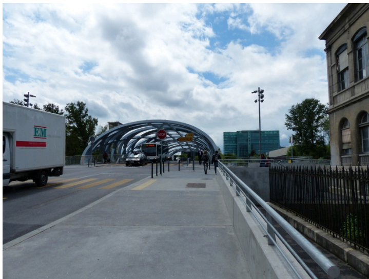
Figure 28 : Pont Hans-Wilsdorf. Source : Louis Rochaix
