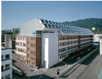
Modification et surélévation du Supertanker, Zurich Stücheli Architekten, Zurich
