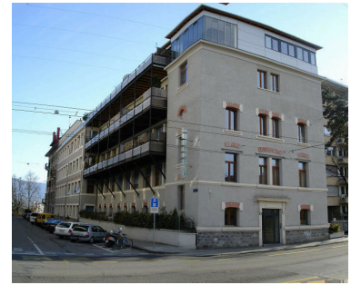
Transformation d'un bâtiment industriel en logement, Rue de Saint-Jean 40, rue Beau-Site 3, Genève.
