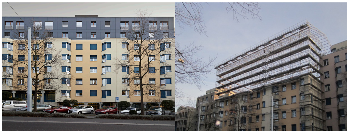
Figure 31 : bâtiment après la surélévation Figure 32 : toiture provisoire durant le chantier (Entretien Laporte 2014)
