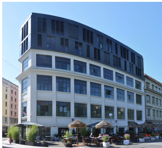
Figure 26 : bâtiment après surélévation (Valance 2014)
