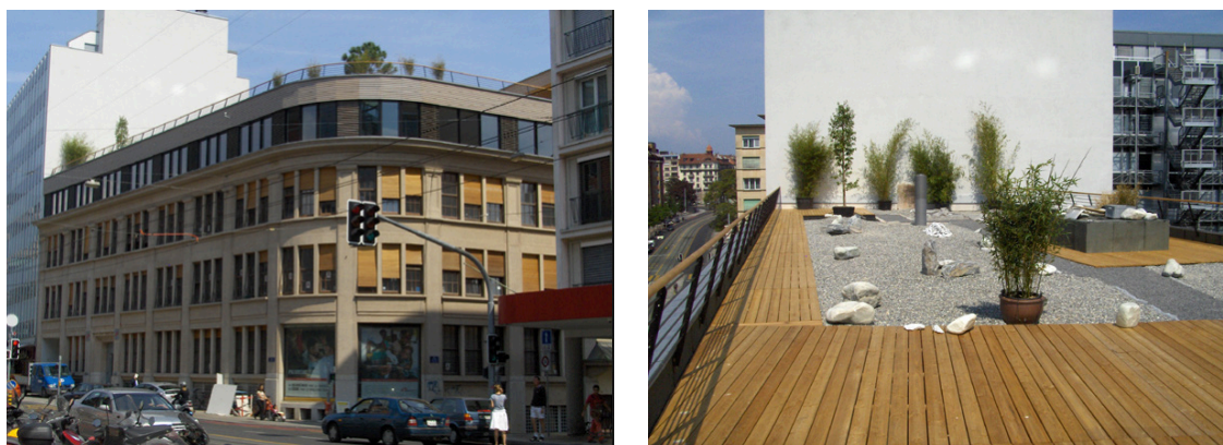
Figure 13 : exemple d'une surélévation - Rue de Lausanne 78, Pâquis
