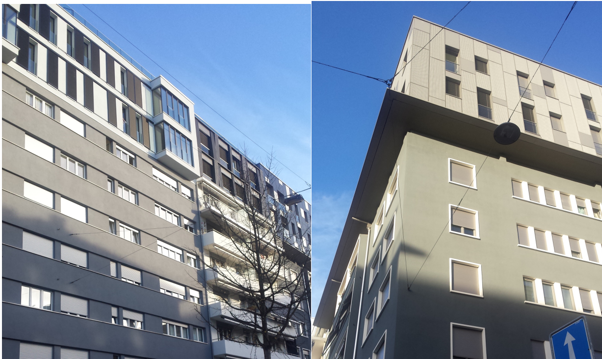
Figure 28 Avenue Lamartine 22-24. Immeuble d'Emma et Beasrat. Source : Braunschweiger, 2016
