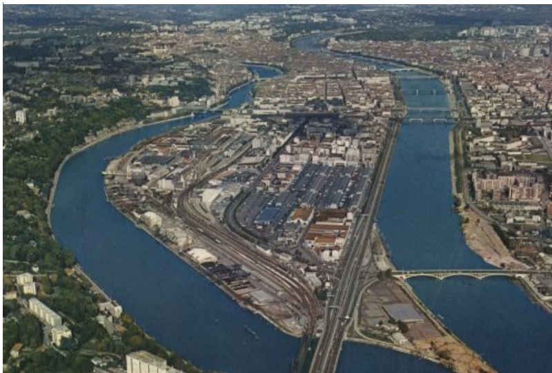
Figure 14 : Vue aérienne de la Confluence en 1980
