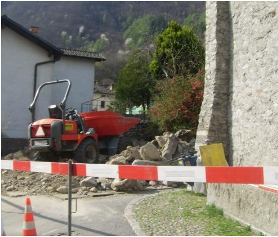
Figure : 73 chantier entre Carrale di Mezzo-via Selva - sécurité
