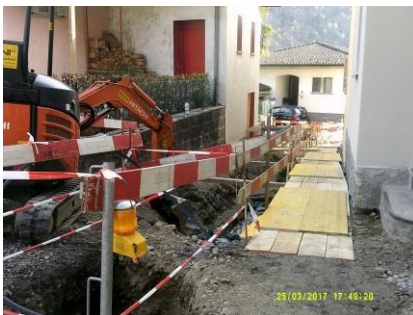
Figure : 75 chantier via Selva - sécurité
