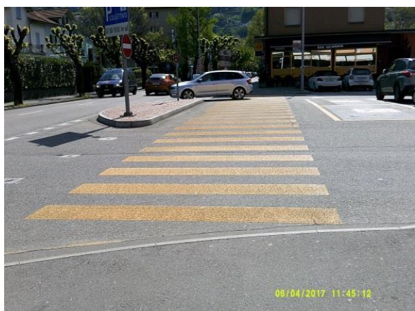
Figure : 55 passage piétons viale Motta - sécurité
