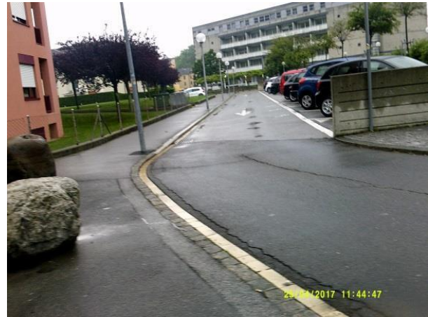
Figure : 58 virage via Mordasini - sécurité
