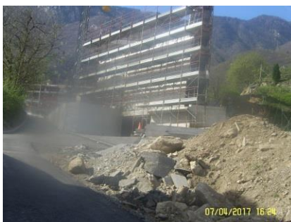
Figure : 78 chantier via dei Gelsi - sécurité
