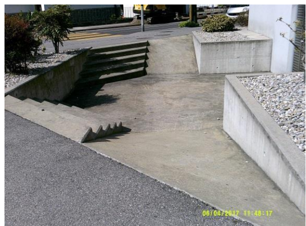
Figure : 62 rampe au carrefour viale Motta-via Mirasole - social et jeu
