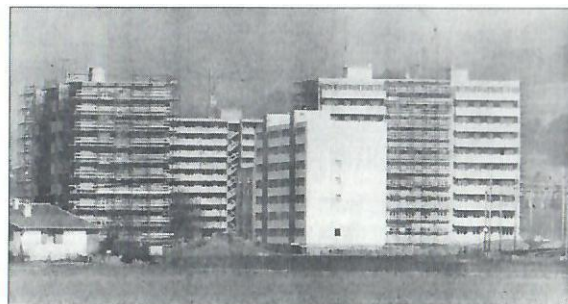
Figure 17 : Photographies du quartier Pierre-de-Savoie (en construction) en 1970
