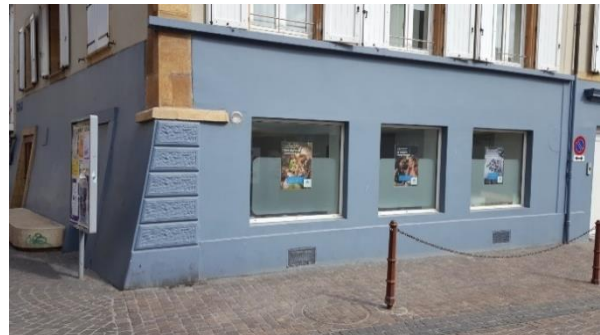
Figure 94 : Rez de la rue du Four peu attractif
