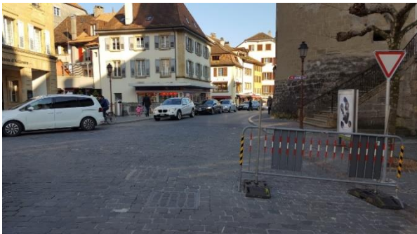
Figure 132 : Pont à côté du château
