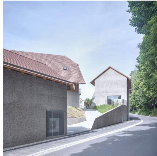
Fig. 35 : Les abords de l'îlot. Au premier plan se trouve la chambre funéraire. Adjacent à la route, c'est le nouveau bâtiment Gonzague-de-Reynold. (Julmy, 2017).
