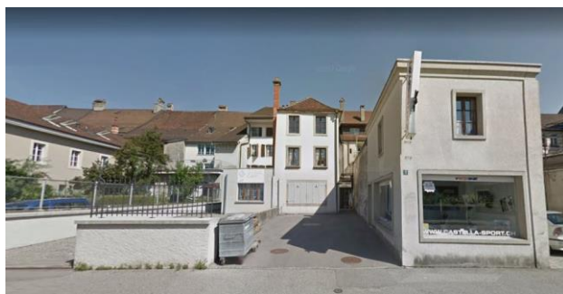
Fig. 25 : Arrière-cour du bâtiment de la Grand-Rue 17. Vue depuis la rue de la Sionge. (Google street map, 2018).
