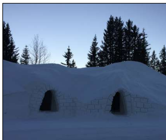
Illustration 23. Entrée du Village Igloo d'Avoriaz, sculptée de briques de glace. Cette photo a été prise au début de la saison d'hiver, ce qui explique que la neige n'est pas encore recouvert les traits des sculptures. (Source : Delsante, 2017)
