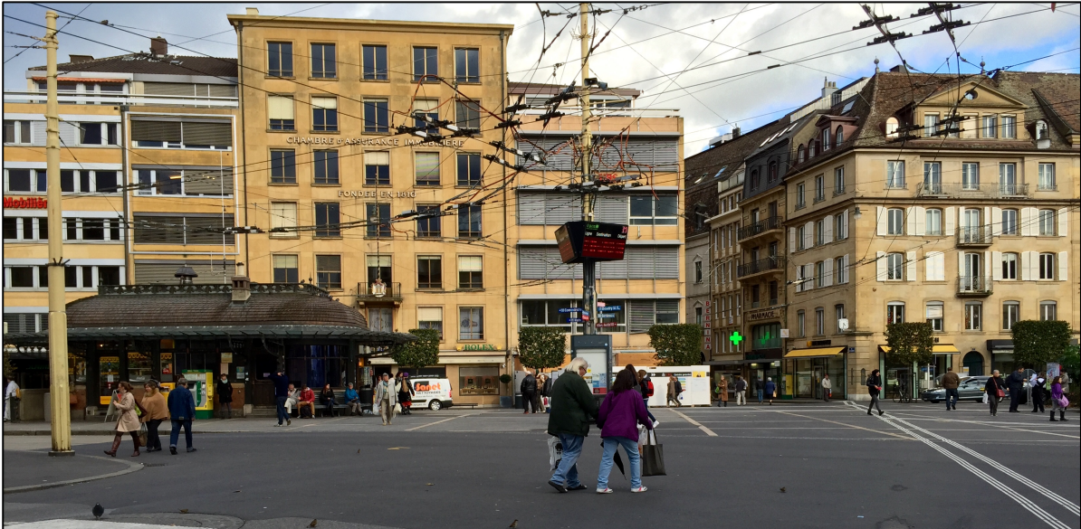
Place Pury, câbles omniprésents
