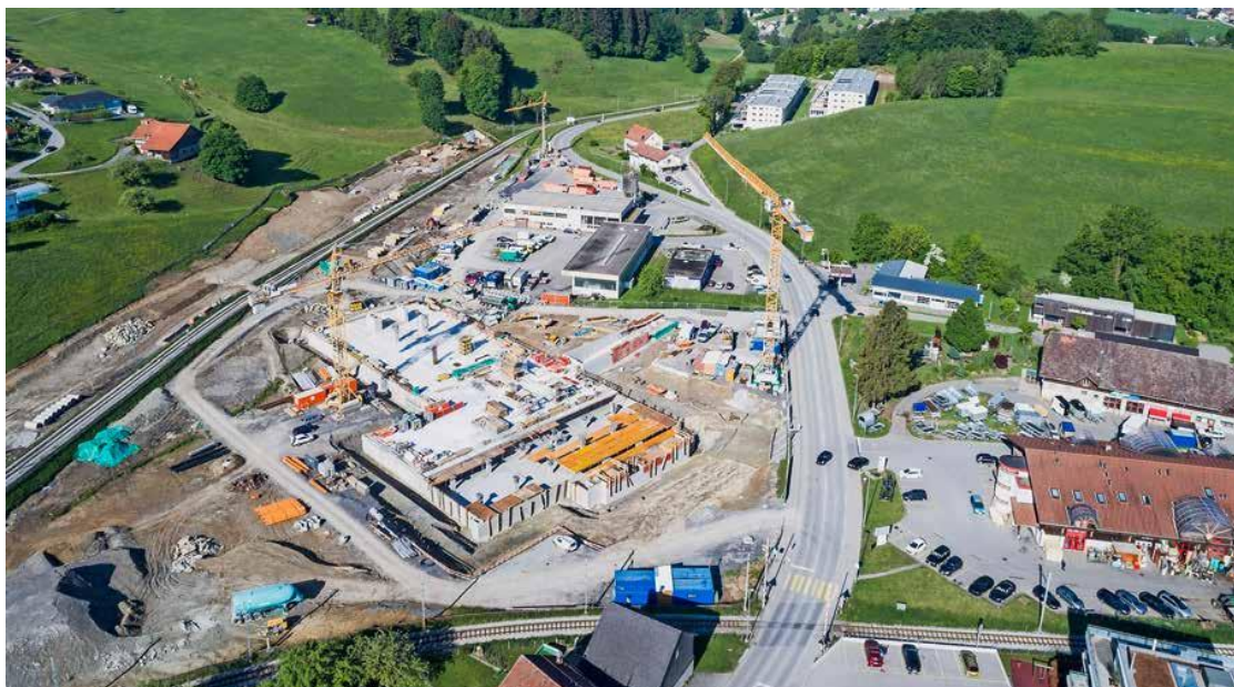
Figure 2 – Chantier de la nouvelle gare de Châtel-St-Denis (FR)
