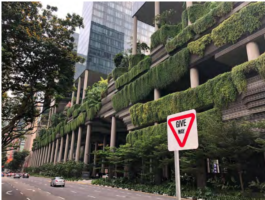
Figure 14 : Park Royal Hotel, mélange de béton, de verre, de végétaux, de main d'œuvre et de capital. (Source : Elie Andlauer)
