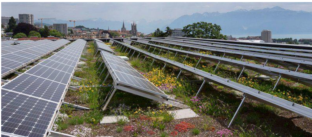
Figure 12 : Végétalisation de toiture à Lausanne ( lausanne.ch )
