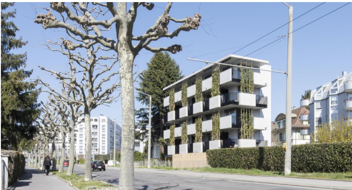
Figure 16 : Immeuble résidentiel à Renens ( dvkarchitectes.ch/fr/realisations/les-fleurs-dehden )
