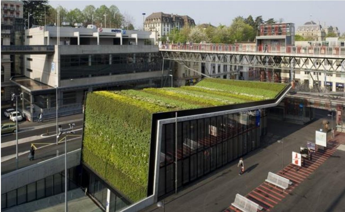
Figure 15 : Bâtiment des TL et de l'interface de transports publics à la Place de l'Europe à Lausanne ( dra4.ch/dra2/projets/1152/interface-des-transports-publics-centre-clientele-tl-transports-lausannois/ )
