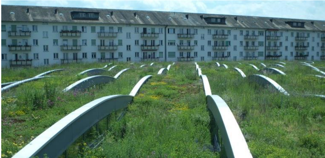
Figure 13 : Végétalisation de toiture à Bâle ( climate-adapt.eea.europa.eu )
