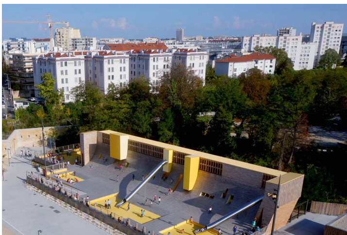
Image 16 La Vague et son insertion dans le parc et le quartier. Source : BASE
