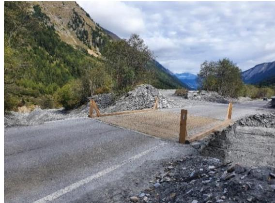
Figure 15 Pont amovible sur la route principale du Val Ferret. Photo: A.Pugin.
