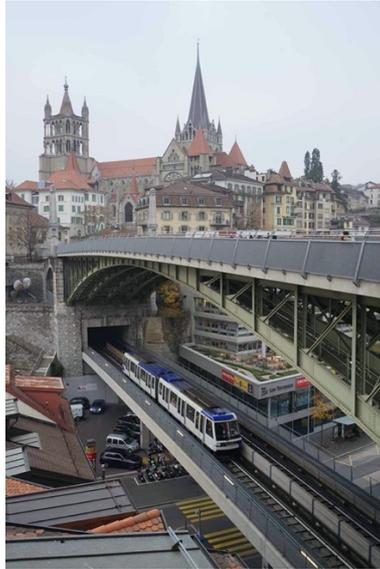
Figure 6 : Le pont Charles Bessières à Lausanne accueillant sur le pont une route, au deuxième niveau les voies du métro m2 et au troisième niveau, la surface du sol accueillant également une route.
