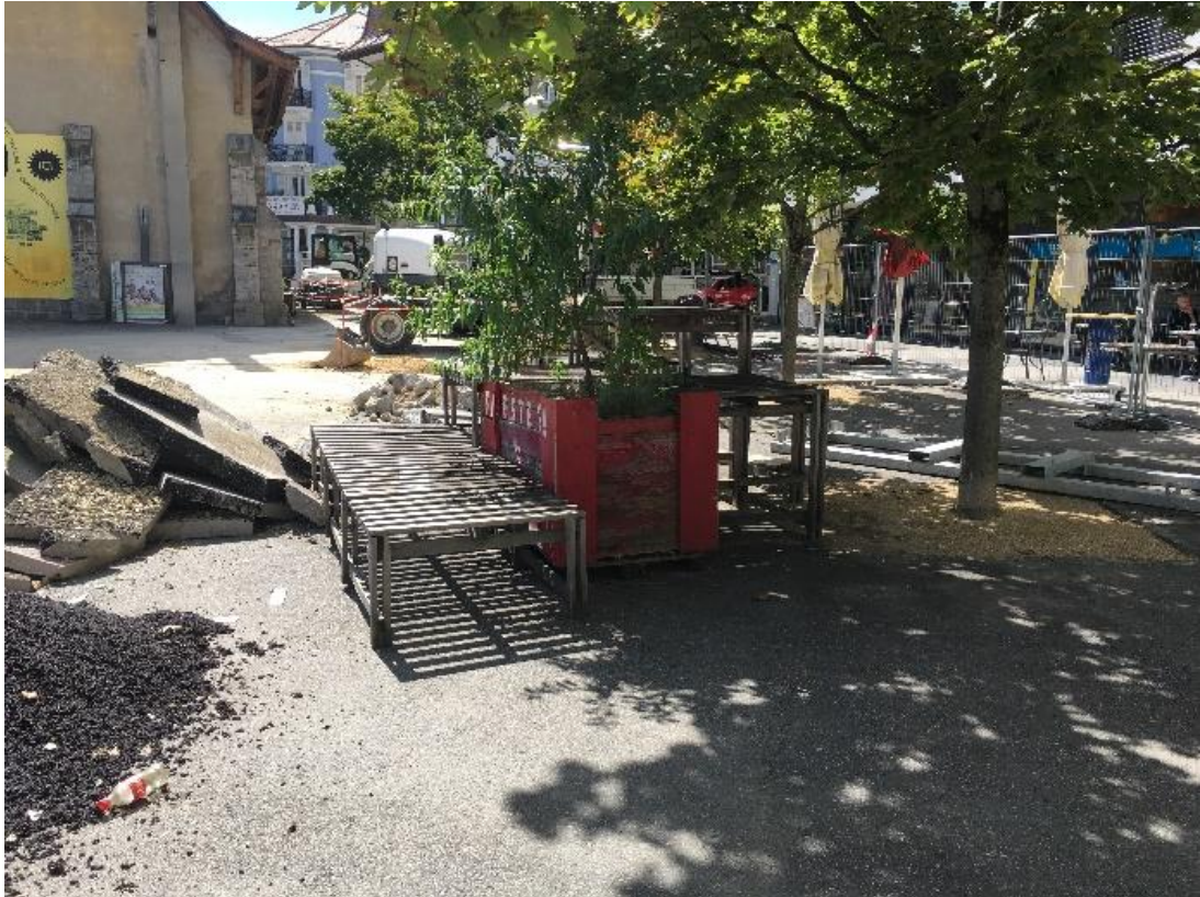
Figure 23 : Structure en étages Source : Auteur, septembre 2020
