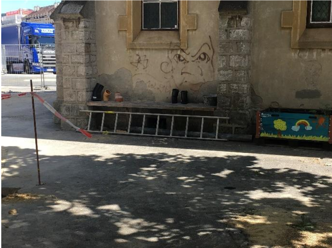
Figure 25: Banc utilisé par les ouvriers Source: Auteur, septembre 2020
