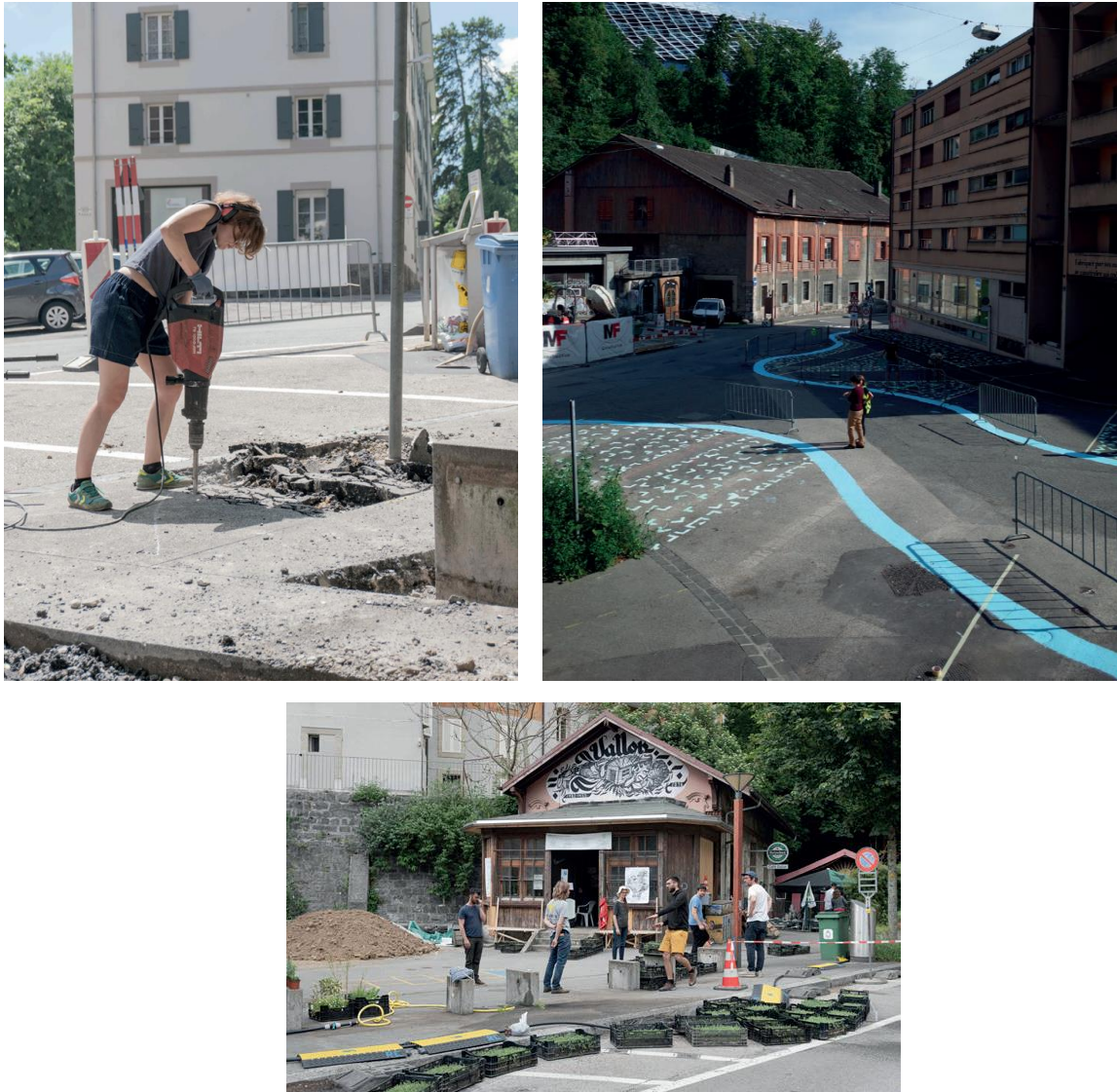
Figure 54 : Interventions sur la place Source : Atelier OLGa
