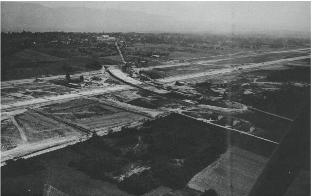
Figure 6. Vue aérienne des travaux d'agrandissement de la piste (1957).
