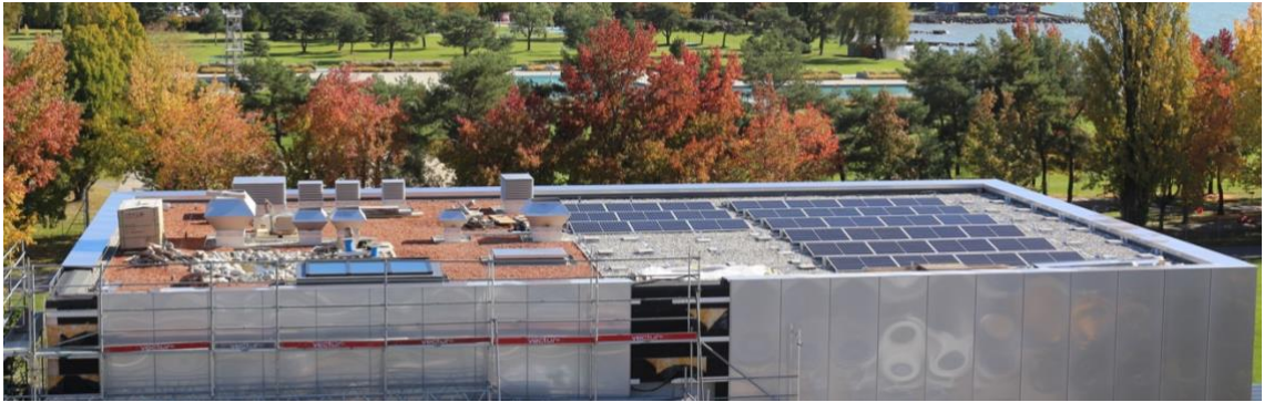
Photo 8 : Panneaux solaires posés en dômes est-ouest sur l'extension (Yann Duchoud)
