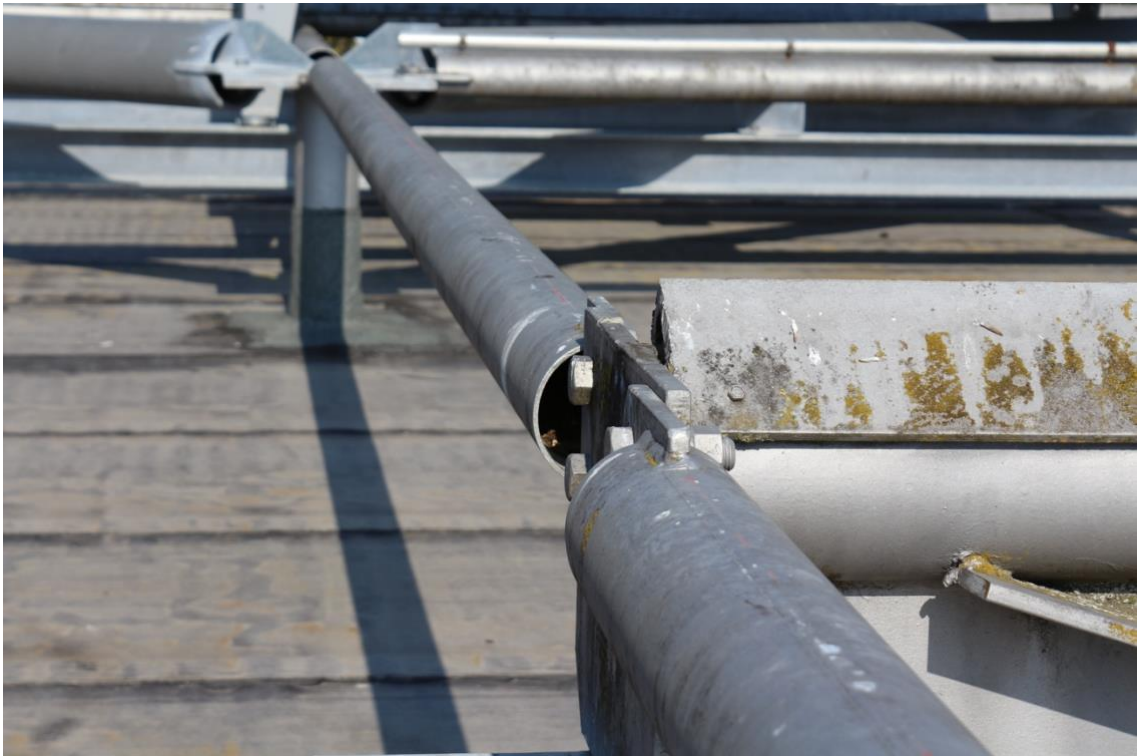
Photo 3 : Tubes de la structure porteuse des toitures de l'aile nord et de l'aile sud (Yann Duchoud)
