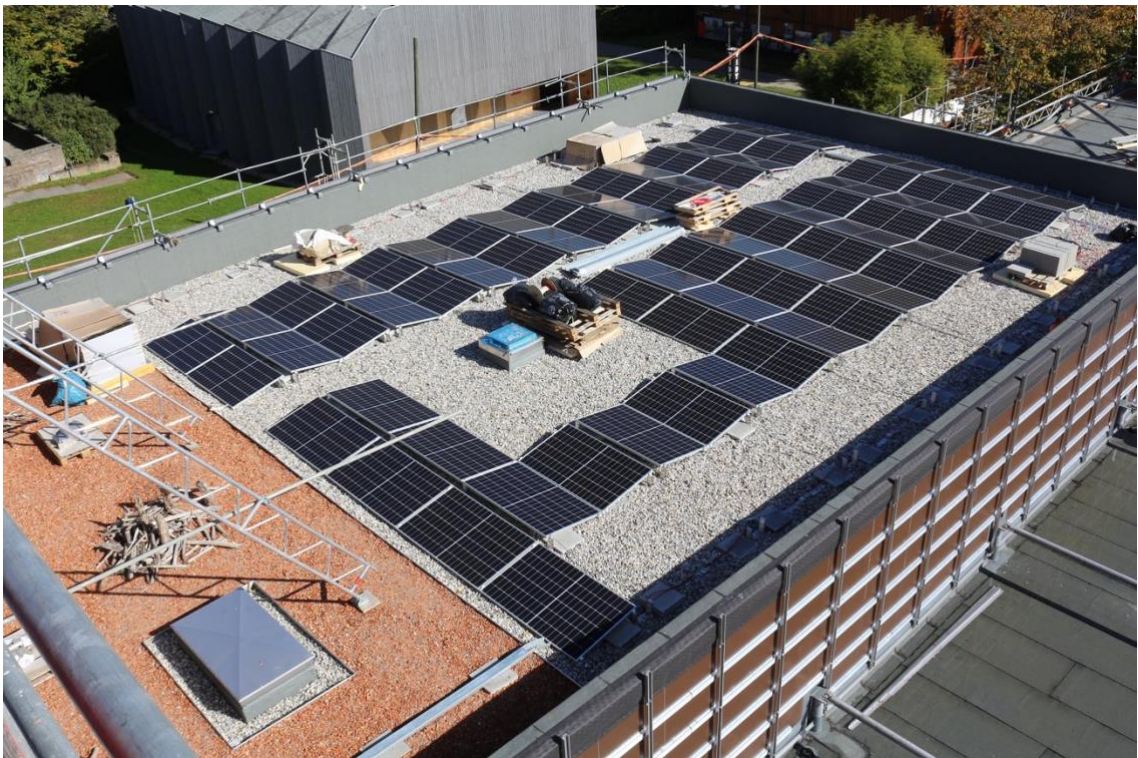
Photo 5 : Séparation entre panneaux solaires et végétalisation sur la toiture de la salle (Yann Duchoud)
