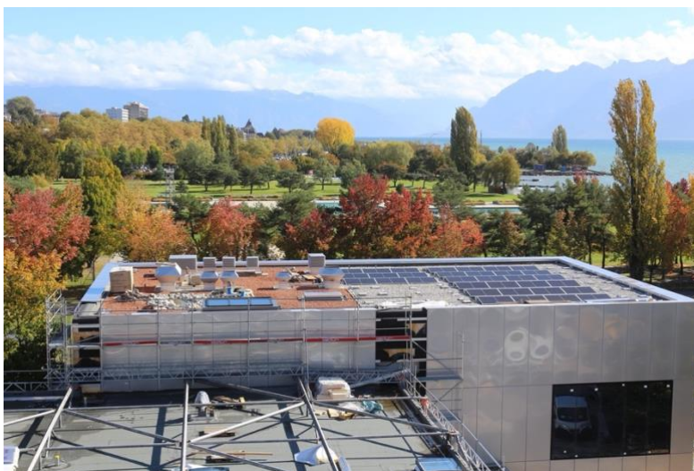
Les toitures du théâtre de Vidy en rénovation (Yann Duchoud)
