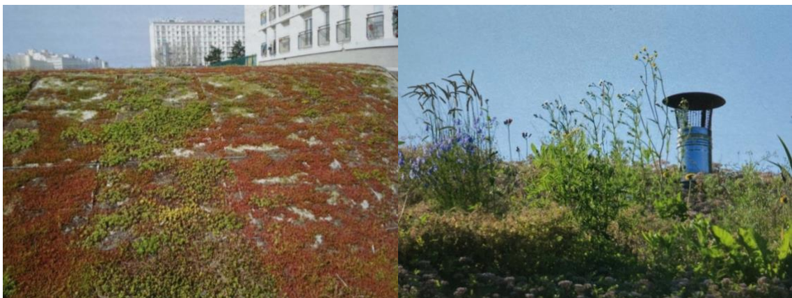
Figure 2 : Système de tapis précultivés (à gauche) et toiture biodiverse (à droite) (Peiger & Baumann, 2018)
