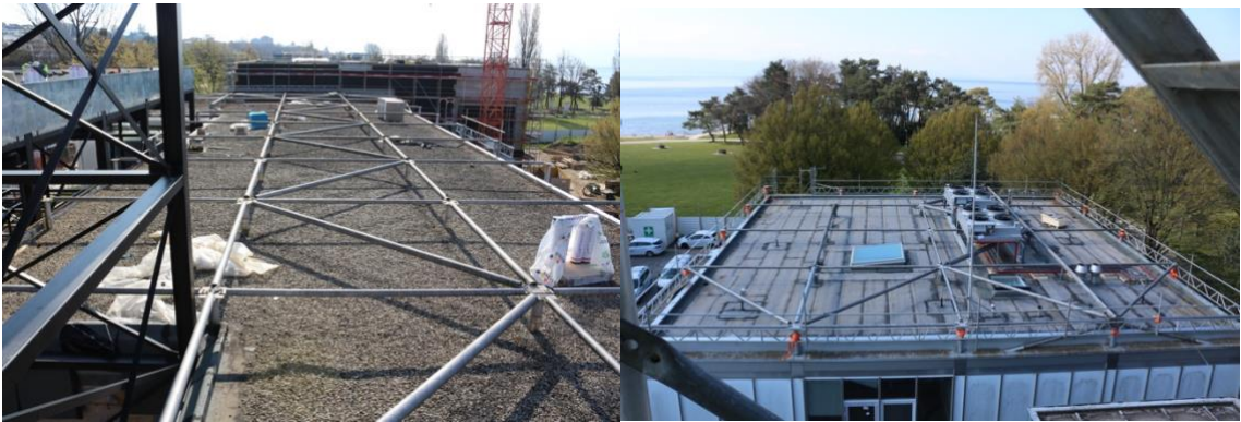
Photo 4 : Toitures de l'aile nord (gauche) et de l'aile sud (droite) (Yann Duchoud)
