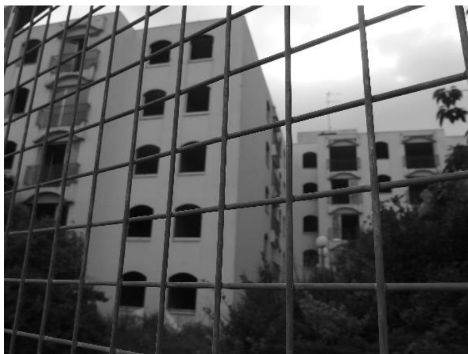
Figure 22 : Foyer pour migrants quelques semaines avant sa destruction. Saint-Ouen. Gilles Magnin, 2021.
