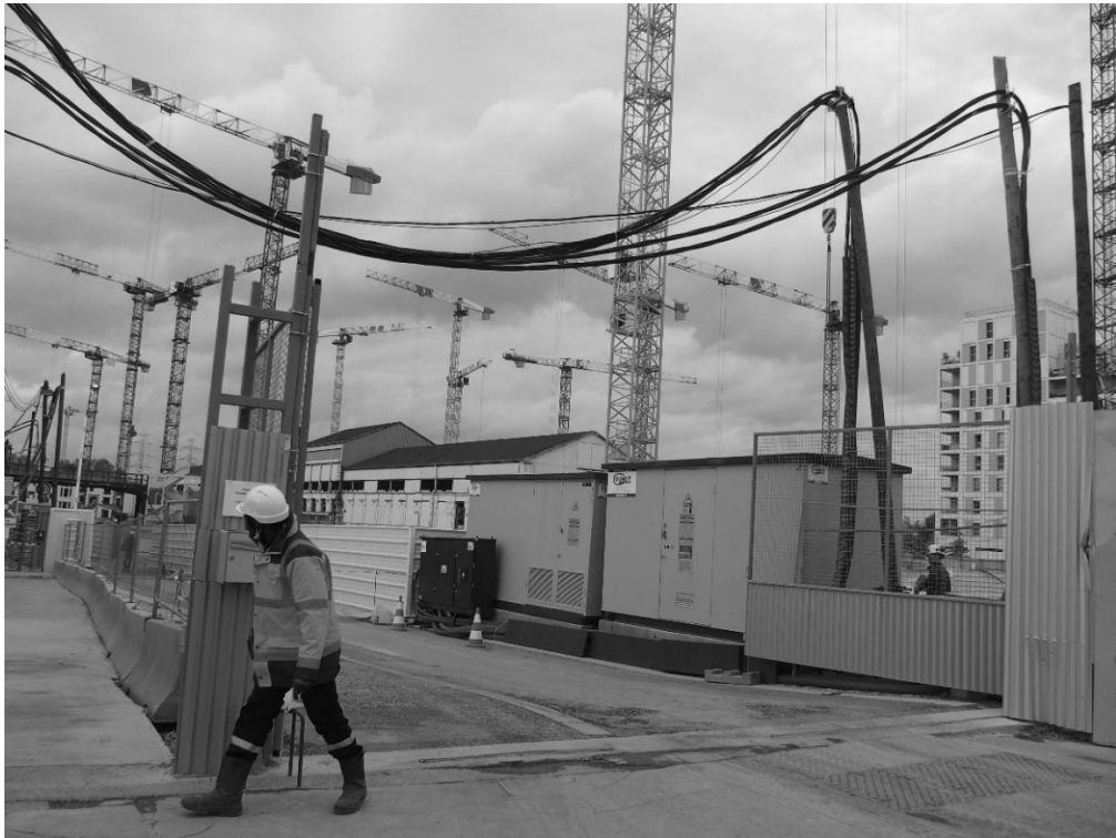
Figure 8 : "Inspection des travaux". Chantier du VO, Saint-Denis. Gilles Magnin, 2021.
