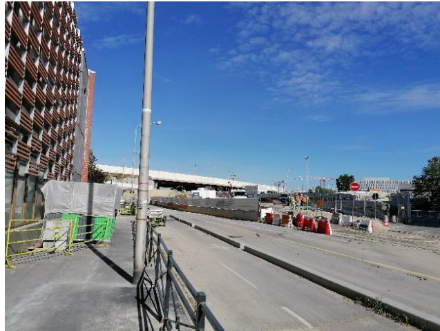
Figure 19 : Bretelle en travaux avec l'école sur la gauche et l'A86 en contrefont. Saint-Denis. Gilles Magnin, 2021
