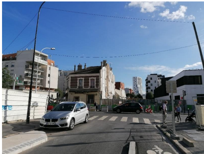
Figure 38 : Réhabilitation d'habitats ouvriers. Saint-Denis. Gilles Magnin, 2021.
