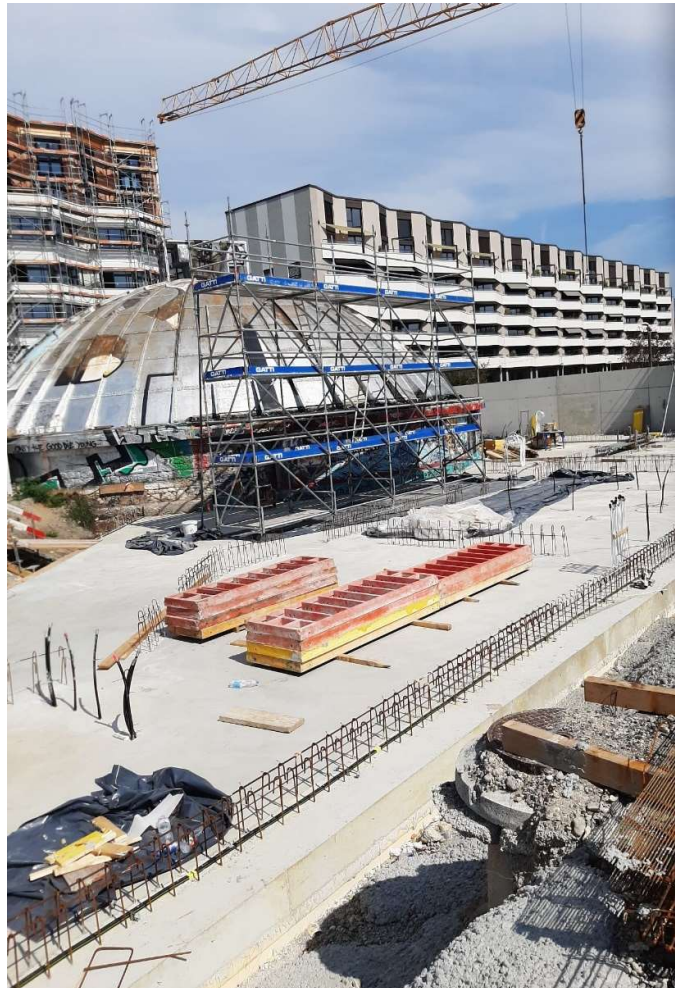
Figure 4 Travaux d'extension de la Coupole. Source : Jeremy Faivre (2022).
