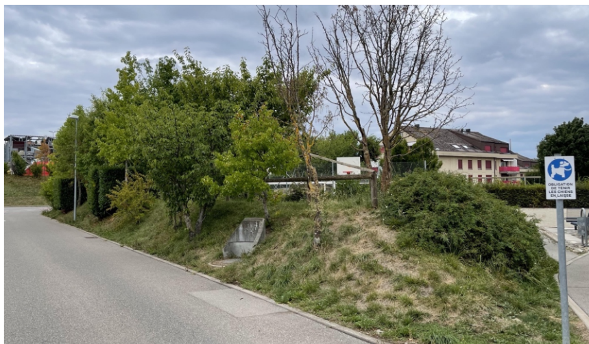
Fig. 4 : talus extérieur du côté nord avec buissons exotiques et végétation herbacée diversifiée. (© Jacques Studer, 18.08.2022)
