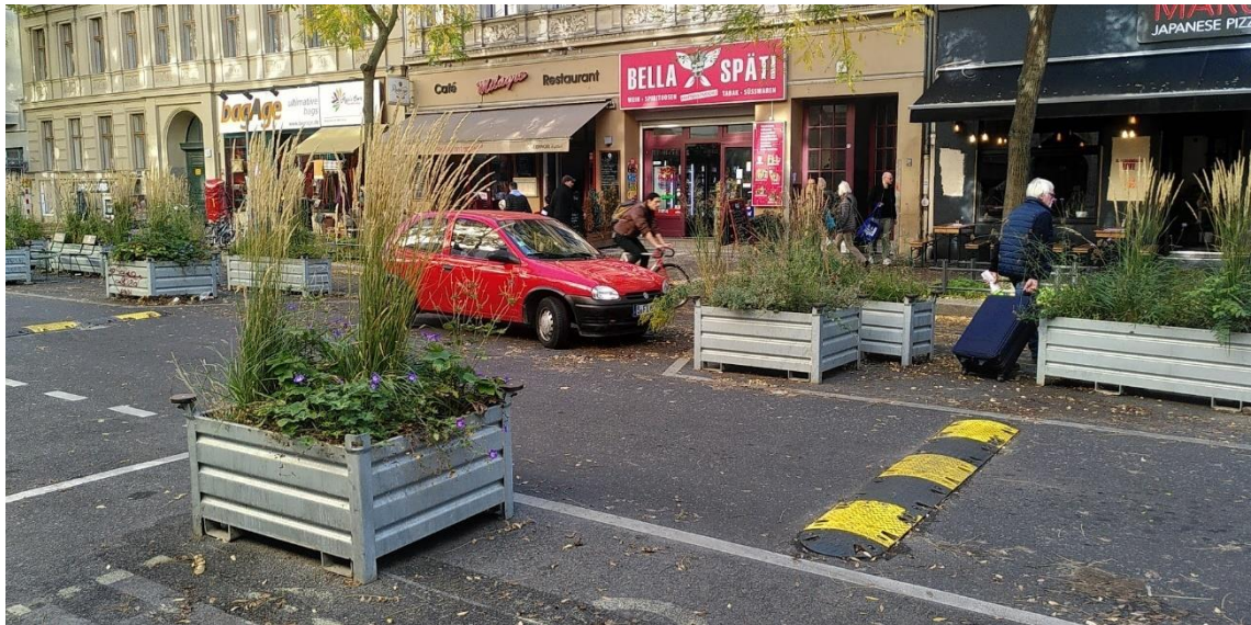
Figure 34: Dos d'ânes pour limiter la vitesse sur la zone 10 (Auteur, 2022)
