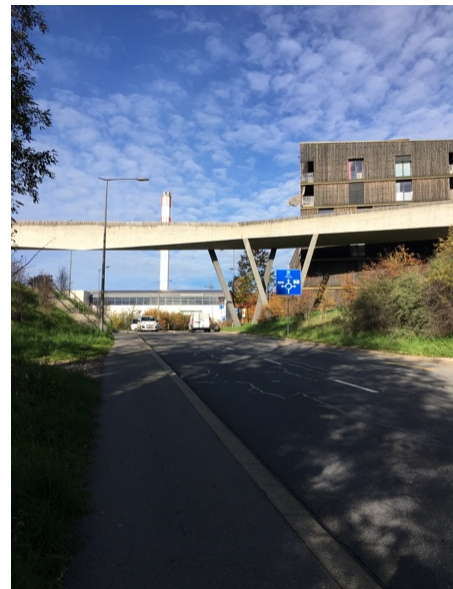
Figure 5 : Route bruyante sous la passerelle
