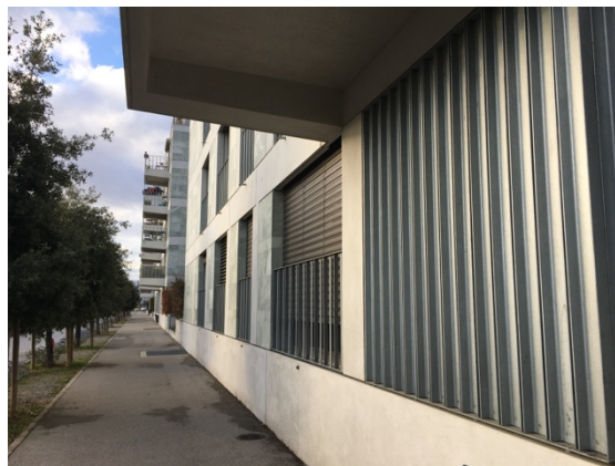
Figure 24 : Surminéralité des habitations
