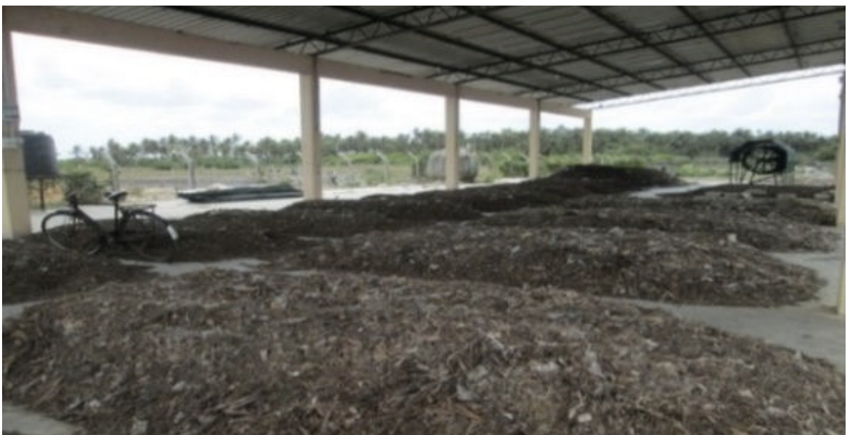
Figure 9: actuelle usine de compostage à Kakaithivu Source : JICA, 2016
