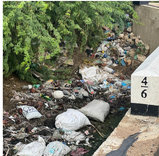
Figure 19: déchets obstruant les canalisations Source : Rajaratnam.R
