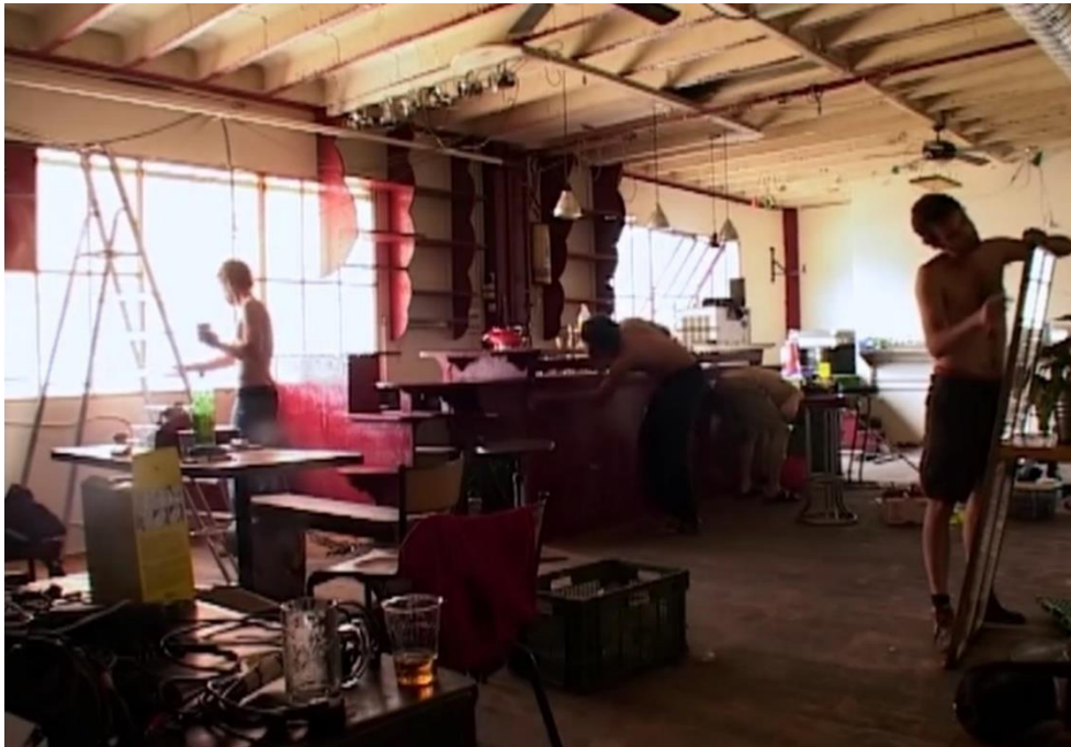
Figure 14: Remise à neuf des intérieurs des bâtiments à Artamis (Paysage Urbain, 2008)
