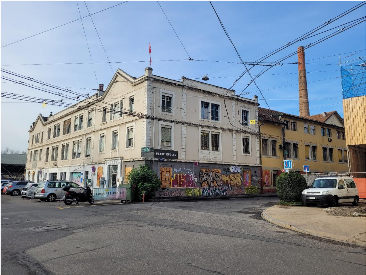
Figure 40: Façade de l'usine Kugler
