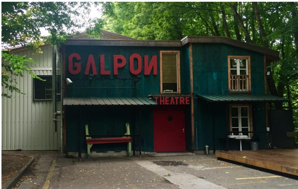
Figure 24: Façade du théâtre Kugler construite à partir de matériaux recyclés (GenèvePasCher, 2023)
