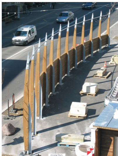
Figure 37 : Claustra en bois durant les travaux du square. Jotterand.ch, s.d.
