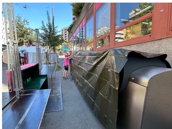
Figure 85 : Bâchage de l'écopoint. Auteur, 2023
