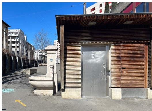
Figure 53 : Entrée des WC. Auteur, 2023
