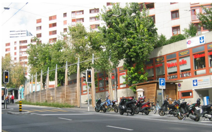
Figure 38 : Vue sur le bâtiment de l'Armée du Salut, accolé au square. Auteur, 2023
