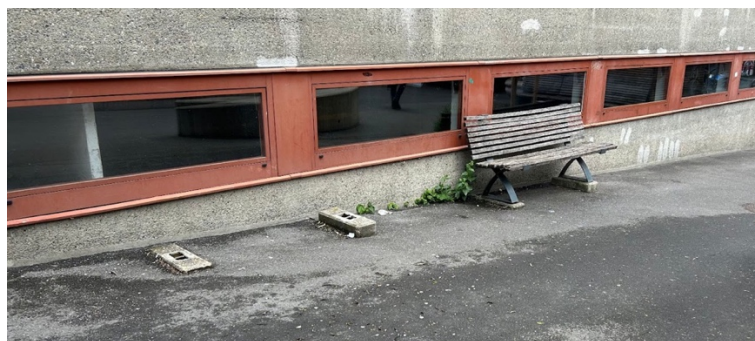
Figure 43 : Banc manquant pour des raisons inconnues. Auteur, 2023
