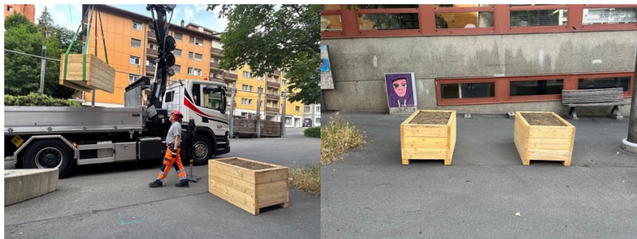
Figure 78 : Livraison et installation des jardins de poche sur la place. Auteur, 2023
