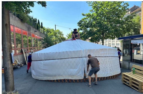
Figure 80 : Installation de la yourte. Auteur, 2023
