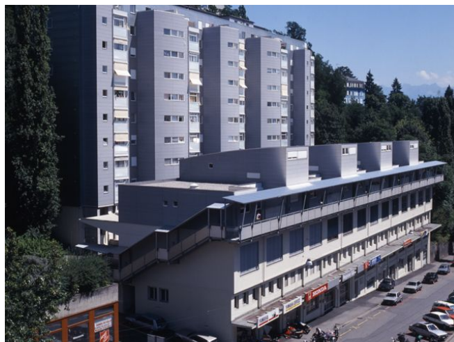
Figure 9 : Adaptation des immeubles situés à la rue de la Borde 12-22 b par l'atelier Cube. Lausanne.ch
