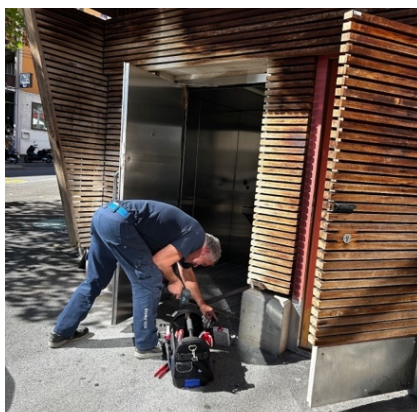
Figure 55 : Employé remplaçant la serrure des WC publics. Auteur, 2023
