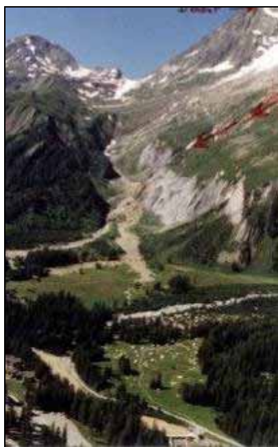
Figure 46 : Extension de la lave torrentielle de 1990 avec, au premier plan, le camping de La Fouly, vue depuis le Val Ferret, (ROUILLER 1997).
