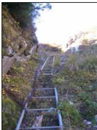
Figure 9 : Vue du secteur DOL03_Di illustrant un des deux passages équipés de chaînes et d'échelles.
