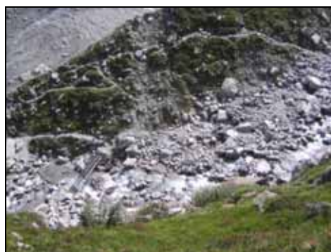
Figure 51 : Pont sur la Reuse de l'Amône dans le secteur ANE06_Da.
