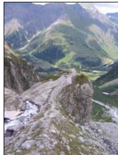
Figure 68 : Vue sur une partie du secteur ANE06.
