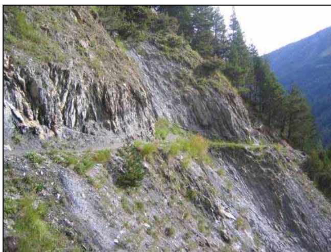
Figure 21 : Vue du tronçon TMB08_Di.
