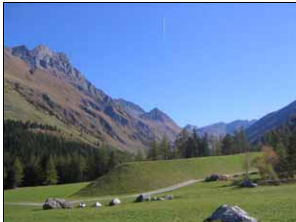
Figure 32 : Digue paravalanche à l'A Neuve.
