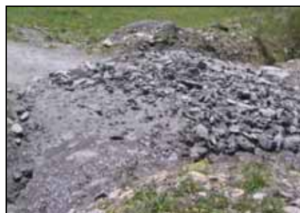
Figure 62 : Dépôts de laves torrentielles sur la route d'accès à l'alpage des Ars.
