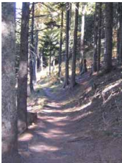
Figure 24 : Sentier large et en bon état dans le tronçon TMB07_Di .
