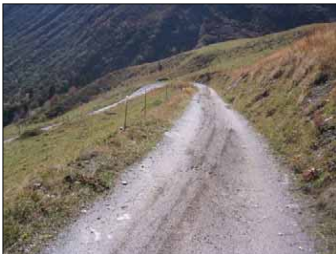
Figure 22 : Route en terre large formant le tronçon TMB17_Di avant l'alpage de la Peule.
