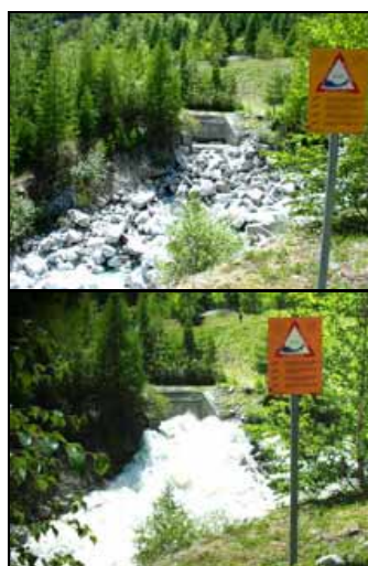
Figure 57 : Situation avant et lors d'un lâcher d'eau à la prise d'eau de Saleina ( www.emosson.ch ).
