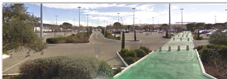
Figure 57 : Cheminement libre pour les piétons, Le Pontet (France)
