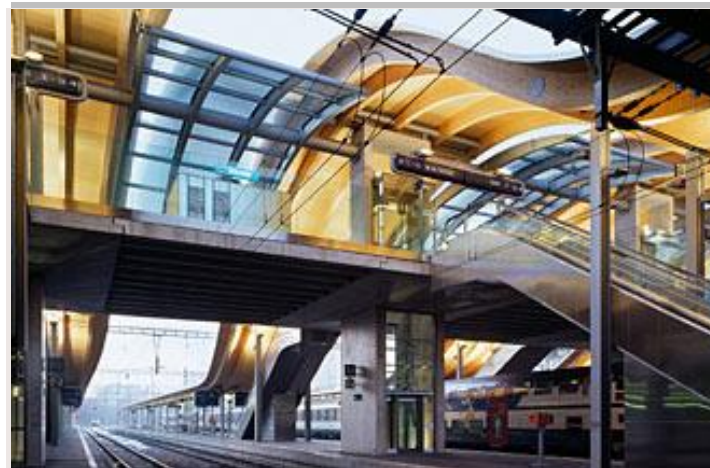
Figure 58 : Passerelle à Berne (Suisse)
