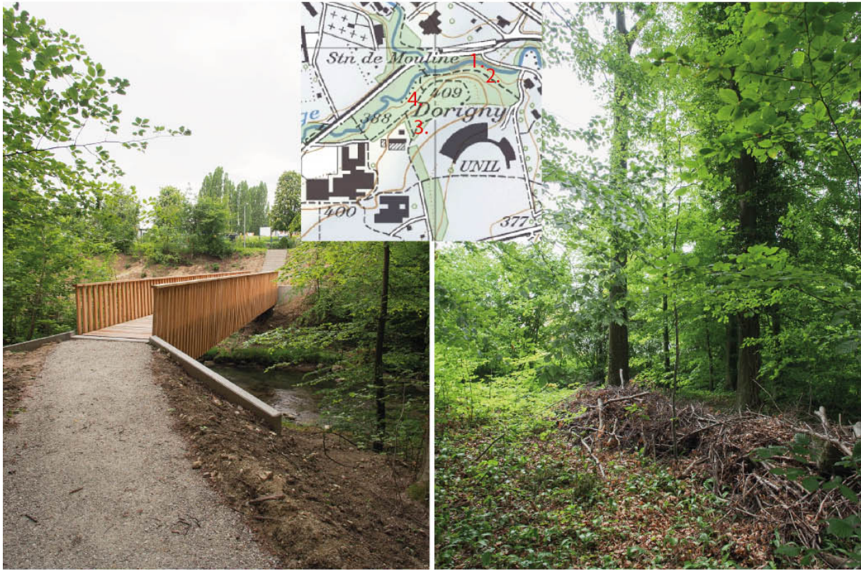
1. Nouvelle passerelle traversant la Chamberonne.
