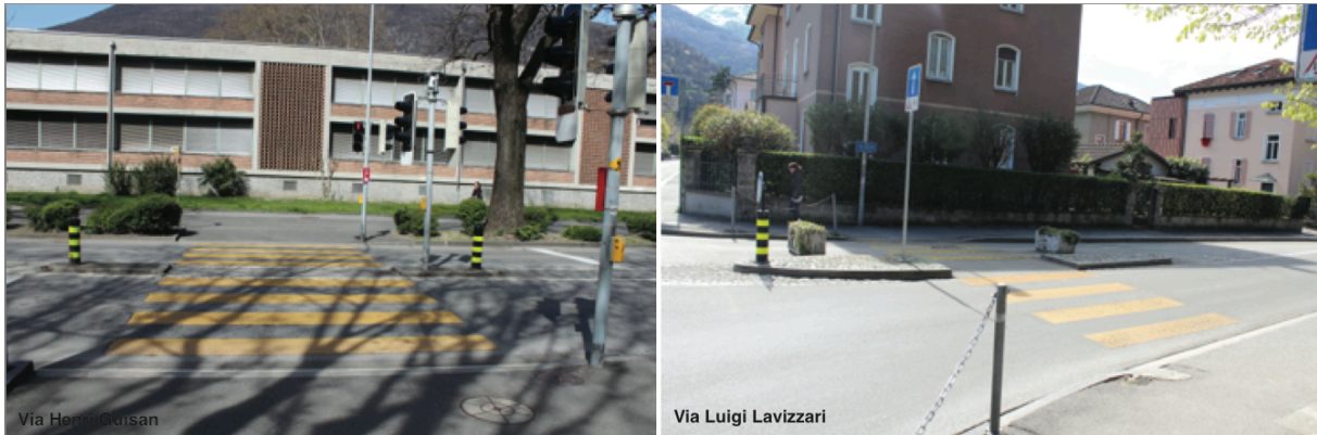
Photo 7 : Exemple des passages piéton avec îlot central [Brancato, 2015]
