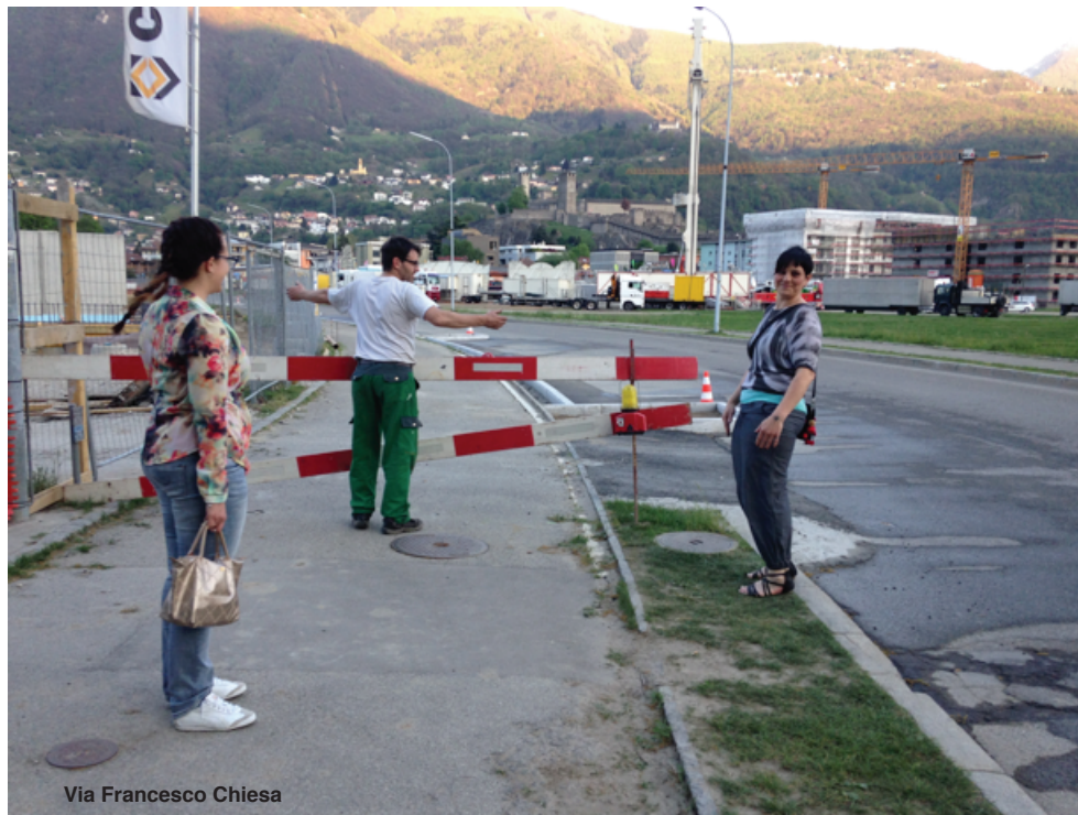
Photo 13 : Trottoir barré pour des travaux [Brancato, 2015]
