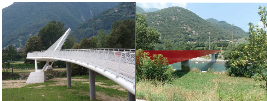
Photo 1 : Passerelles piétonnes qui relient les deux côté de la rivière 25
