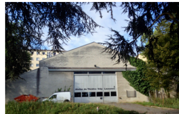
17. Dépendance du théâtre de Vidy ateliers de construction
