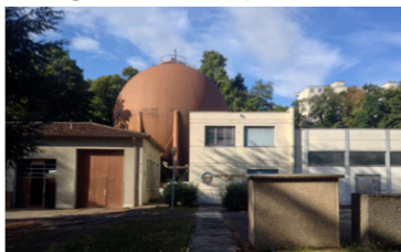
19. Bâtiments liés à l'exploitation du gazomètre
