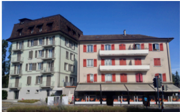
13. Immeubles d'habitation de l'Avenue du Chablais
