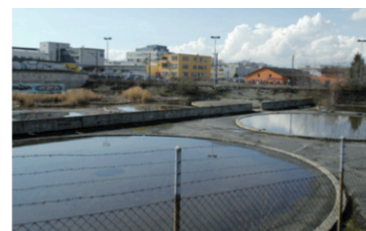
24. Fondation des anciens dépôts Pétroliers (photo de ceux du quartier du Chêne, source: SDIM, 2012, p. 44)
