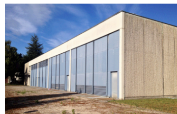
6. Poste électrique du Galicien (PEG)
