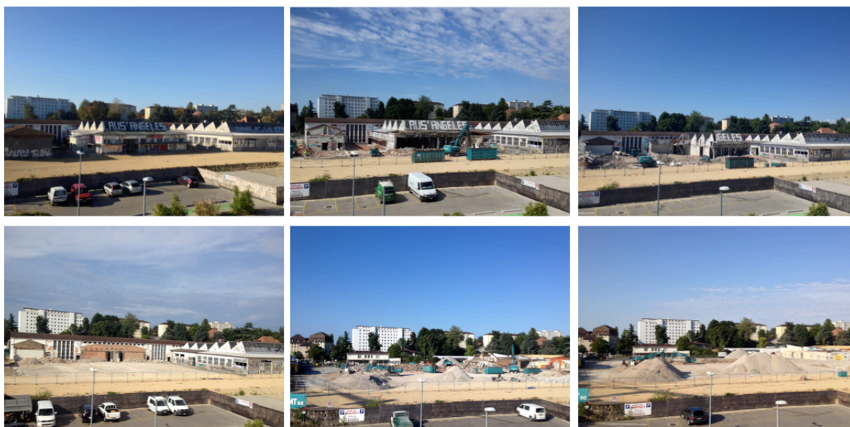
Figure 57: La démolition des abattoirs, de mai à août 2015
