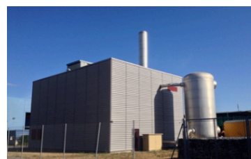
3. Chaufferie du chauffage à distance (CAD)
