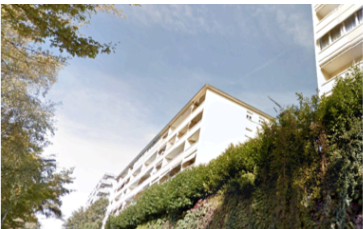
16. Immeubles d'habitation de l'Avenue de Longemalle (source: Google Map)
