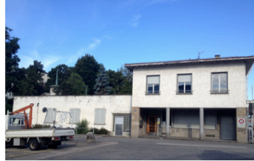
11. Bâtiment administratifs des abattoirs
