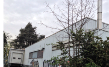
12. Bâtiment pour chargement de camion, lié au SCAB?
