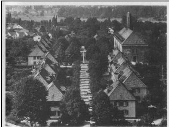
73 Vue dans l'axe en direction ouest-sud-ouest. Etat actuel.
