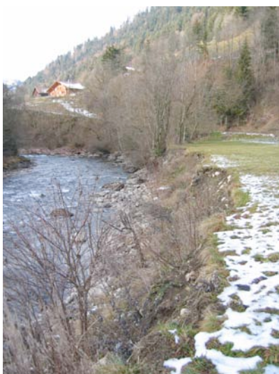
Photographie 13 : Érosion en rive droite en amont du méandre du Chamaveau avec éperons démantelés
