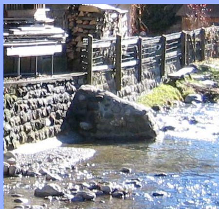
Photographie 3 : Éperon en rive droite de la Torneresse
