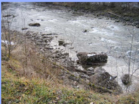
Photographie 2 : Éperon démantelé en gabions en rive droite au Chamaveau
