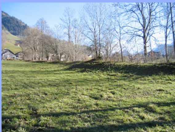
Photographie 4 : Terrassement en rive droite du torrent des Planards
