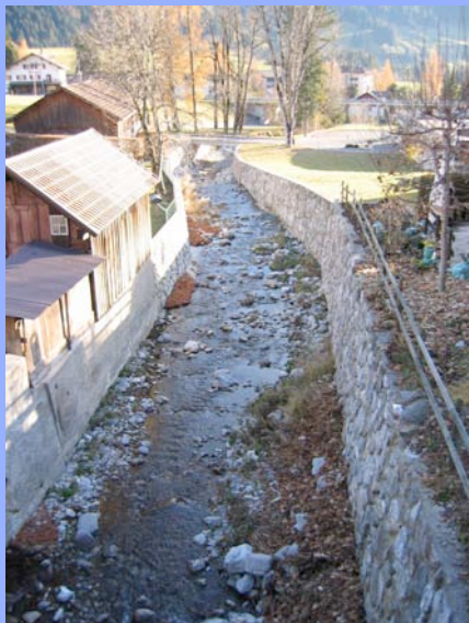
Photographie 5 : Murs en béton et en rocher de part et d'autre des Bossons
