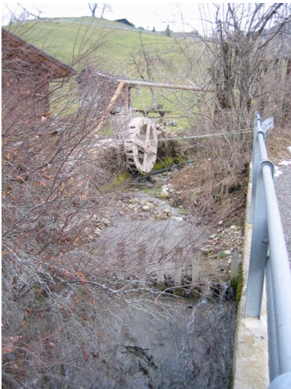
Photographie 23 : Moulin sur le ruisseau du Mont avec en premier plan le grillage servant à retenir les alluvions avant le parcours souterrain du cours d'eau.
