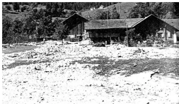
Photographie 18 : Crues de 1940 : Propriétés du Berceau envahies par les alluvions du ruisseau des Mérils (Jacot, 1999, 166)
