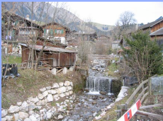
Photographie 6 : Seuil sur le ruisseau de la Leyvra
