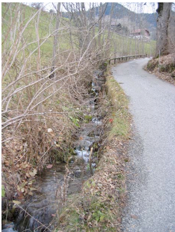
Photographie 15 : Route de 3 e classe construite sur le mur canalisant le ruisseau du Mont
