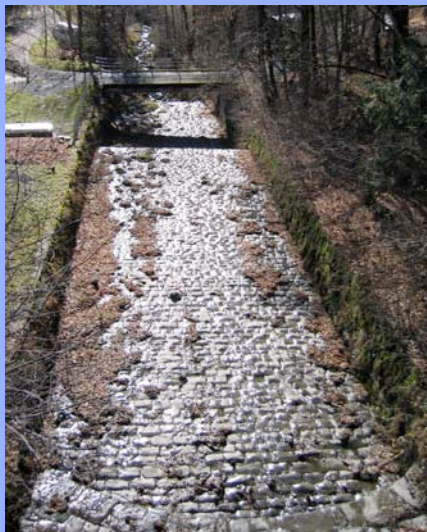
Photographie 7 : Pavage artificiel du fond du lit de la Frasse à Rossinière avec seuils en escalier en aval de la route cantonale
