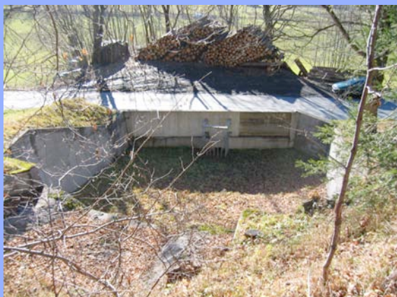
Photographie 8 : Dépotoir du Rafour. L'ouverture destinée à l'écoulement de l'eau est protégée contre l'obstruction par une cage métallique. Sur la droite : les planches en bois peuvent être enlevées pour évacuer les alluvions.
